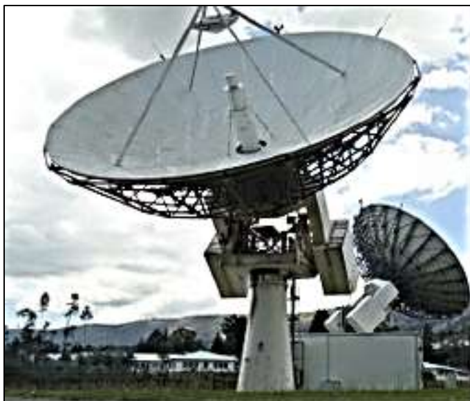
Figura 28. Fotos de las antenas de la estación terrena
