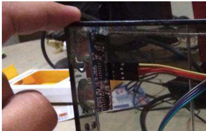
Figura 61. Cables de conexión de sensor ultrasónico
