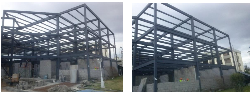
Figura 146. Edificio de aulas de la Escuela de Policías en Pusuquí
