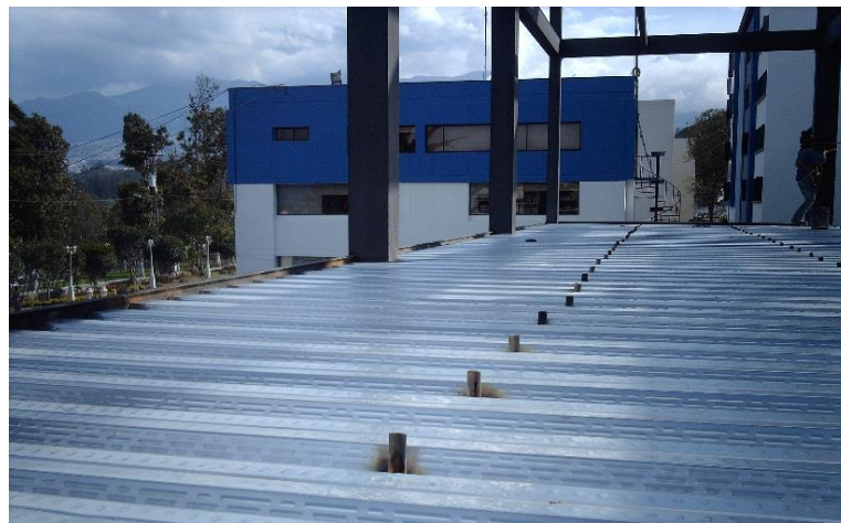
Figura 148. Sistema Mixto de piso
