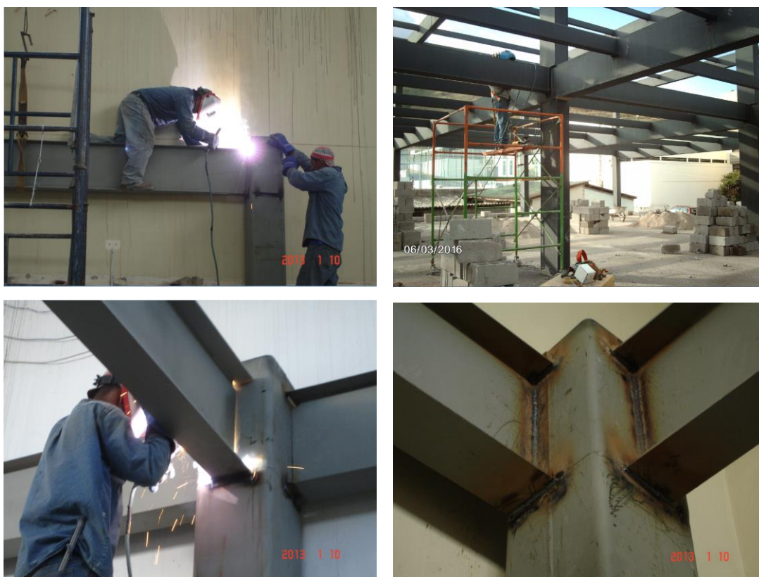
Figura 9. Unión viga - columna
