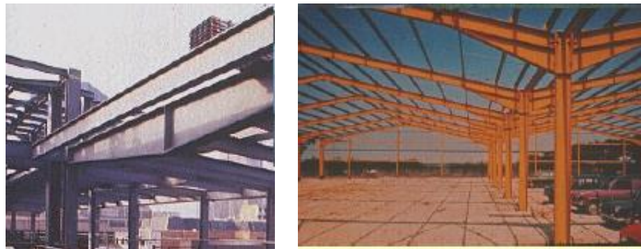
Figura 19. Vigas de canto variable (Oviedo, 2009)
