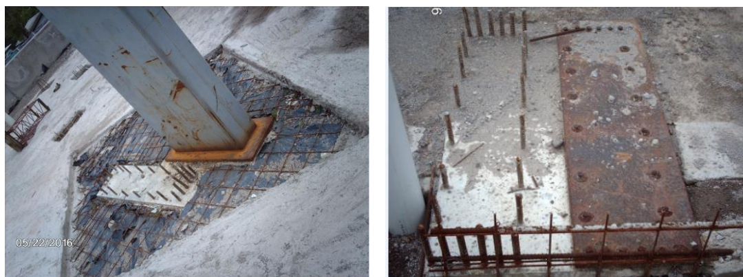
Figura 13. Detalle de la placa metálica de anclaje
