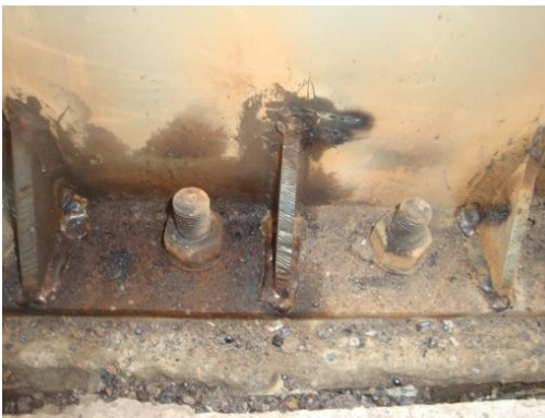
Figura 12. Detalle de pernos, aletas y placa metálica
