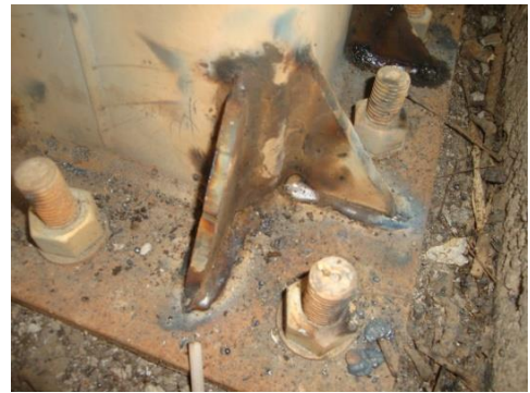
Figura 12. Detalle de pernos, aletas y placa metálica
