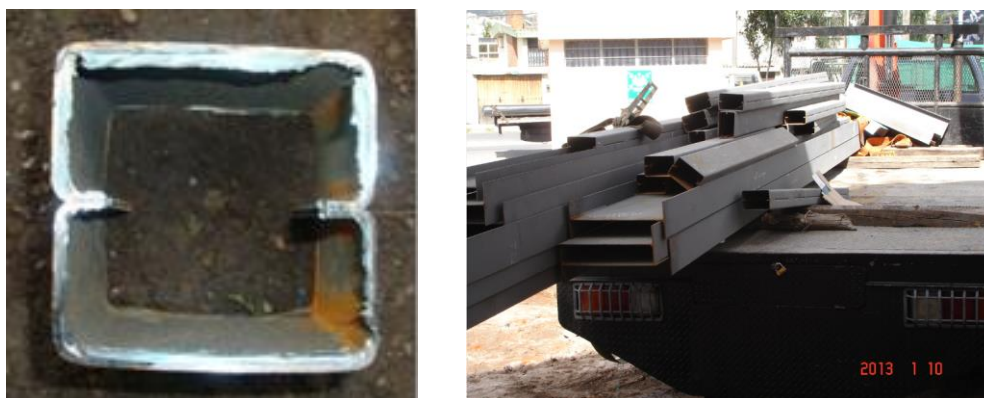
Figura 2. Columna rectangular formada por dos perfiles tipo G
