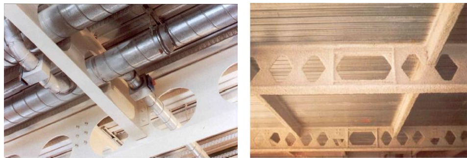
Figura 18. Vigas de alma abierta (Oviedo, 2009)
