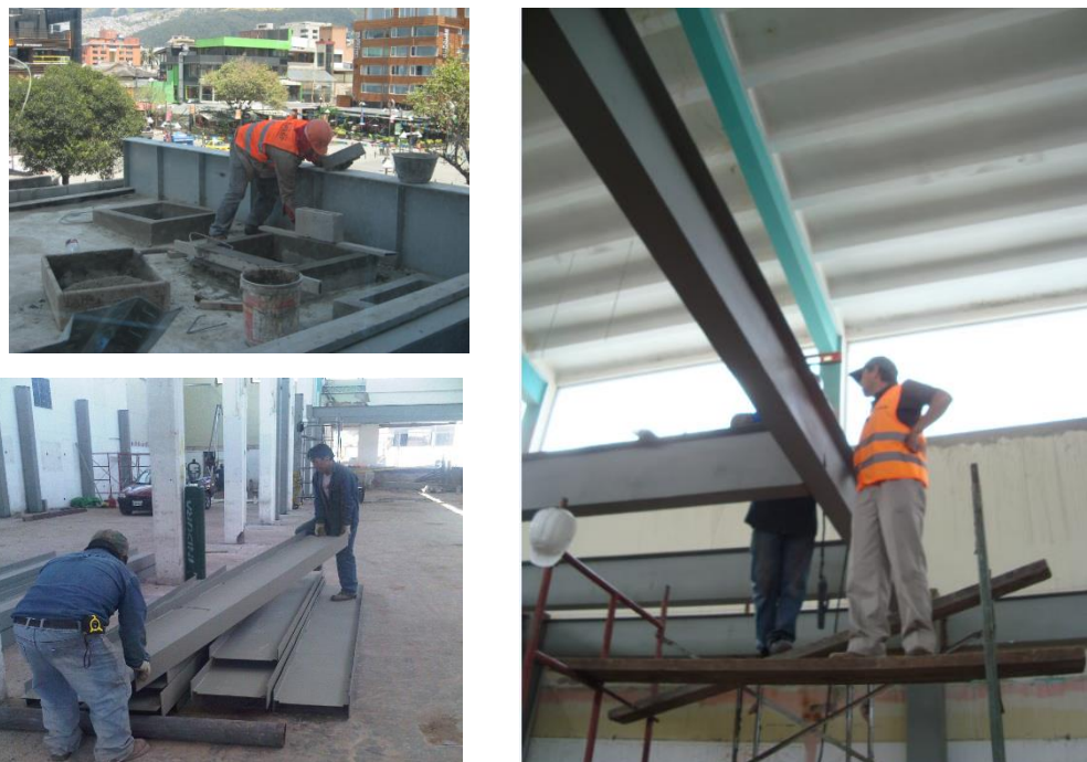
Figura 4. Vigas Tipo I
