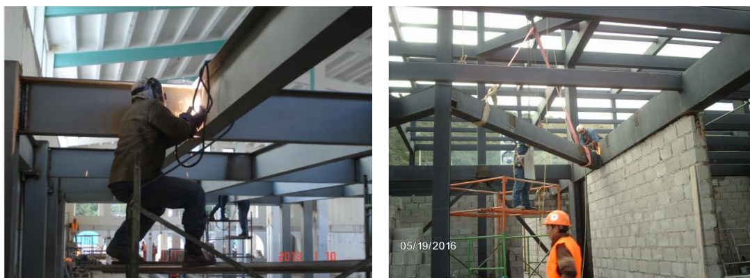
Figura 8. Unión entre vigas
