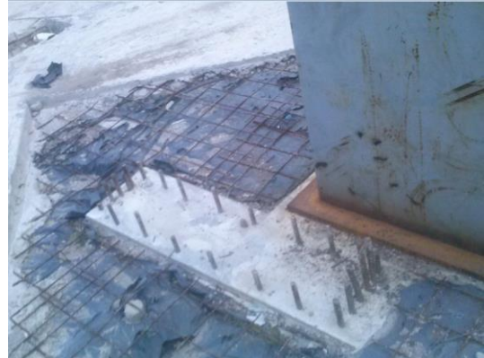
Figura 12. Detalle de pernos, aletas y placa metálica
