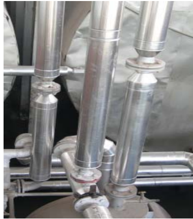
Figura 3.1 Línea de asfalto aislada
