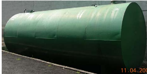
Figura 3.7 Tanque de almacenamiento de agua
