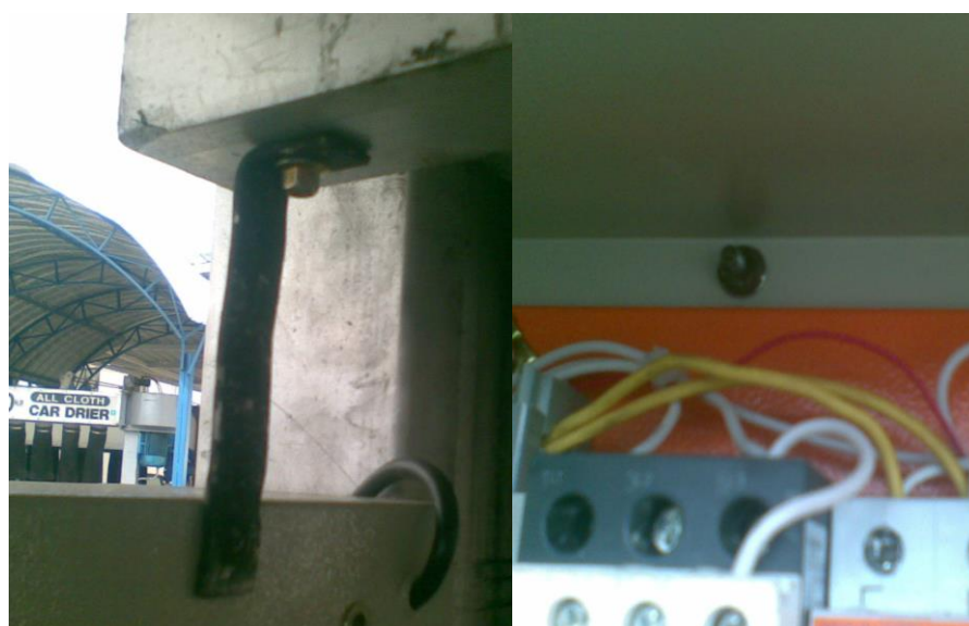
Fig. 5.7.1 Platina en forma de L que sujeta al tablero de control en su parte superior 177
