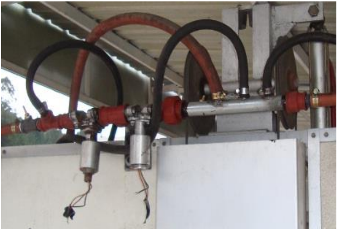
Fig. 5.4.1 Distribución general de mangueras (Flauta) 153
