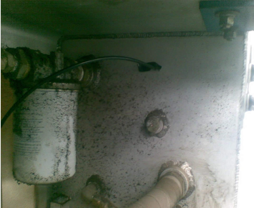
Fig. 5.1.5.3 Tanque de reserva de aceite para el sistema hidráulico 150
