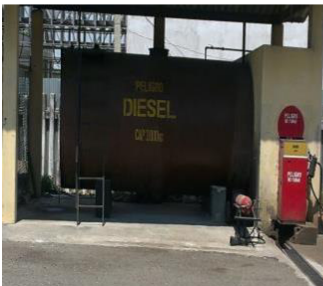
Figura 65. Exterior. Hospital Militar de Guayaquil
