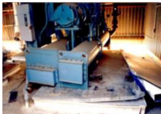
Figura 62. Izq. Anclaje Generador Hospital Militar de Guayaquil. Der. Foto FEMA E74 6.4.1.1-1
