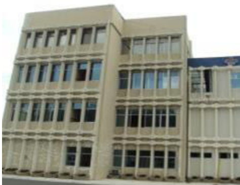
Figura 32. Fachada, Bloque lateral izquierdo. Hospital Militar Guayaquil
