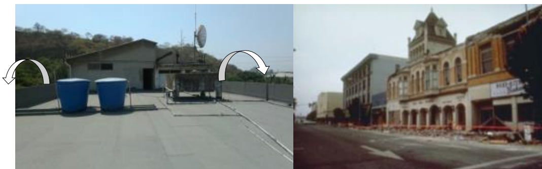
Figura 25. IZQ. Último piso bloque lateral derecho. DER. Foto FEMA E74
