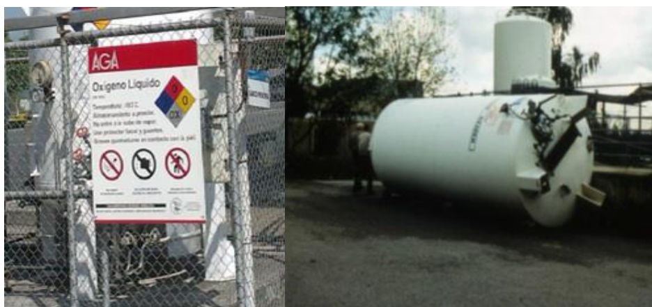
Figura 115. Izq. Señalética de seguridad industrial. Der. FEMA E74 6.4.2.1-2
