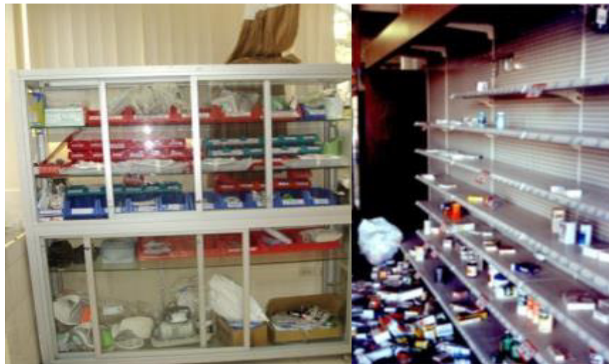
Figura 111. Izq. Área Emergencia. Der. Foto FEMA E74 6.5.4.1-2
