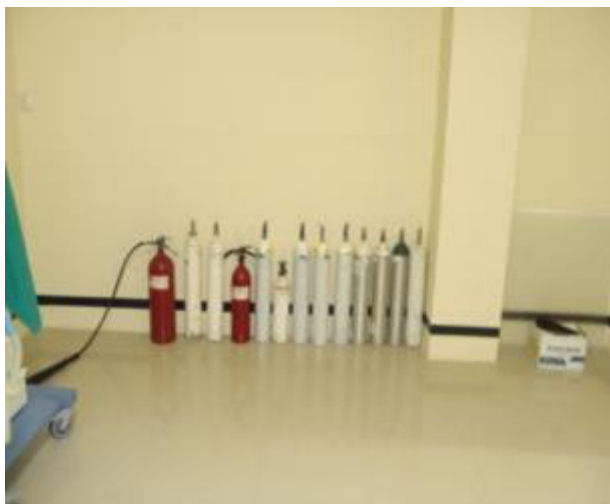
Figura 142. Primer piso. Área de quirófanos
