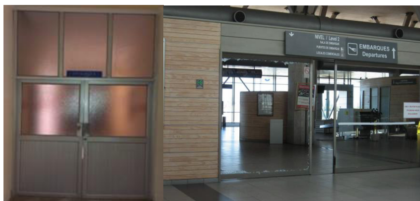
Figura 54. Izq. Mampara. Hospital Militar de Guayaquil. Der. Foto FEMA E74 6.3.2.3-2
