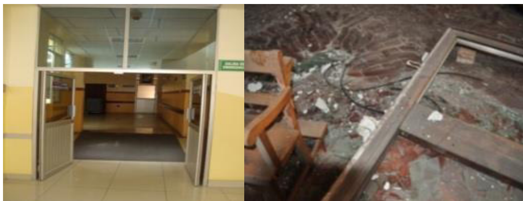
Figura 50. Izq. Segundo piso. Área de consultas. Der. Foto FEMA E74 6.3.2.3-3
