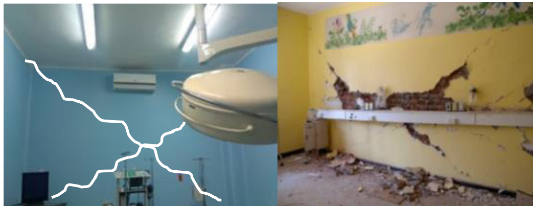
Figura 37. Izq. Área Quirófanos. Der. Foto FEMA E74 6.3.2.1-5
