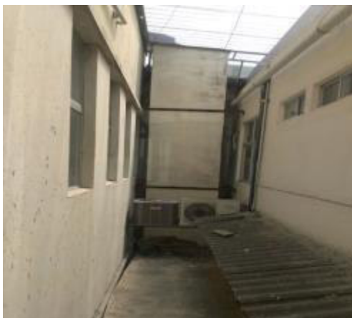
Figura 94. Bloque central. Hospital Militar de Guayaquil
