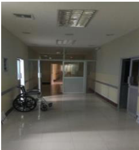
Figura 49. Área de Quirófanos. Hospital Militar Guayaquil
