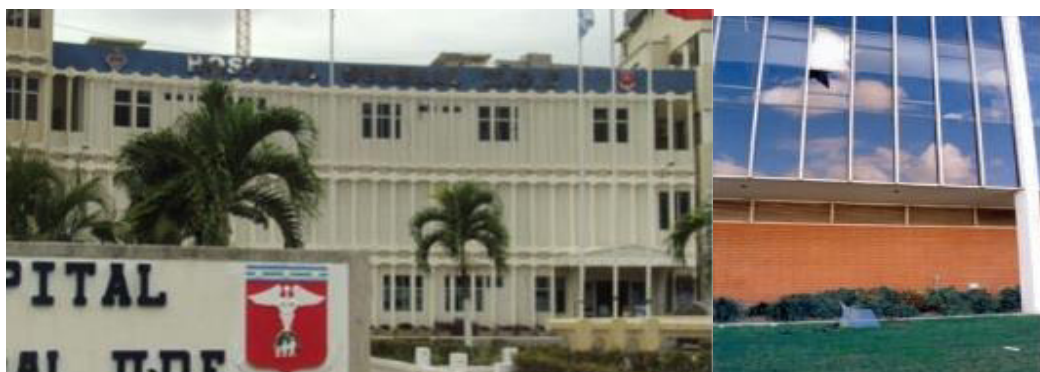
Figura 33. Izq. Fachada, Bloque central Hospital Militar de Guayaquil. Der. Foto FEMA E74
