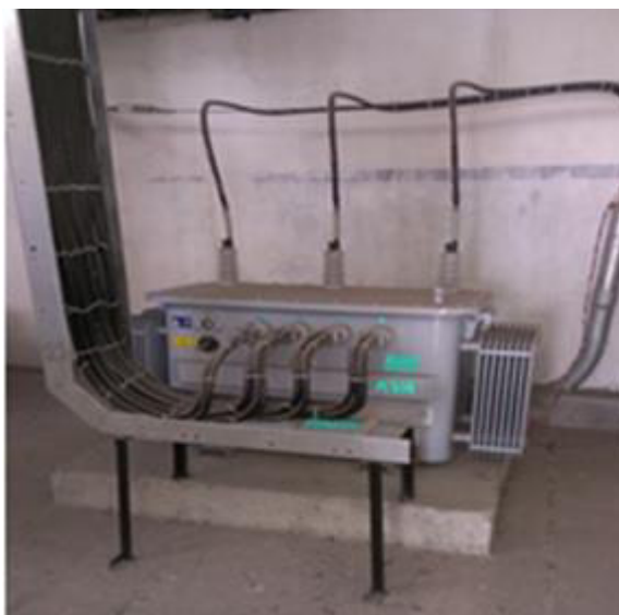
Figura 72. Planta baja. Bloque central. Hospital Militar de Guayaquil Movimientos fuertes pueden causar desplazamientos y ruptura en sus conexiones.
