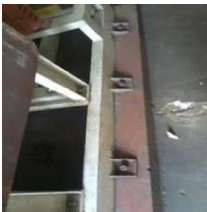
Figura 62. Izq. Anclaje Generador Hospital Militar de Guayaquil. Der. Foto FEMA E74 6.4.1.1-1
