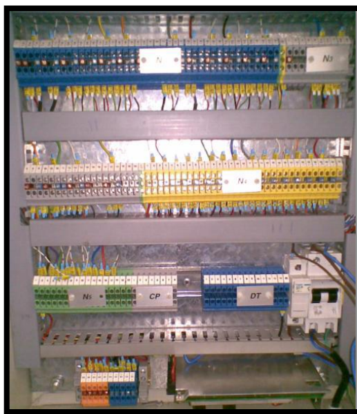
Figura 36 Tablero eléctrico
