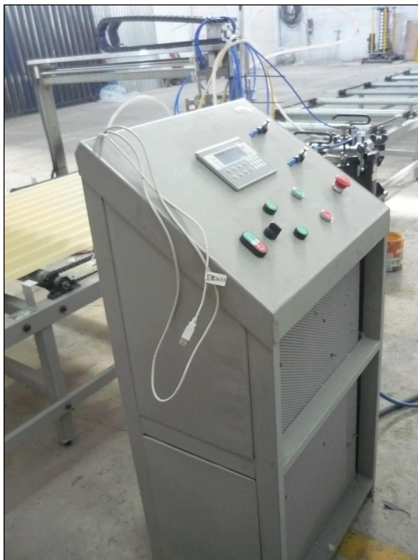
Figura No. 4.14: Montaje del armario de control parte frontal
