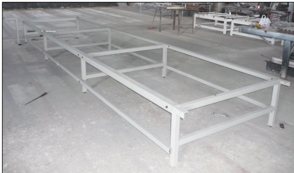
Figura No. 4.1: Montaje de la estructura
