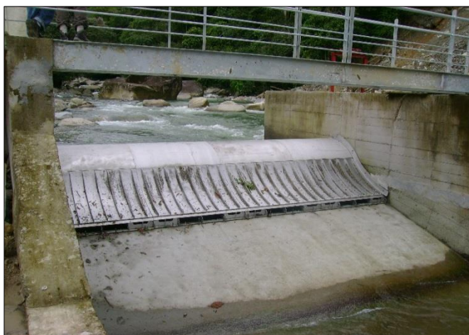
Figura 3.-Vertedero Control de excesos.
