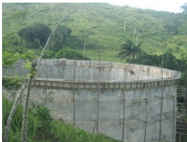
Figura 25: Tanque sin techo Fuente: (Vega & Rodriguez, 2009)
