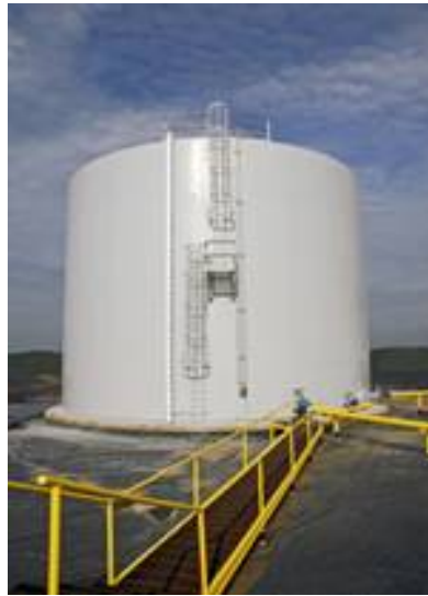
Figura 34: Escalera vertical de un Tanque Atmosférico Fuente: (AGI, 2012)
