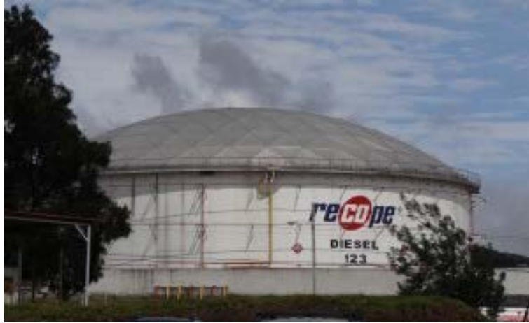
Figura 28: Techo de un Tanque Atmosférico Fuente: (Recope, 2013)
