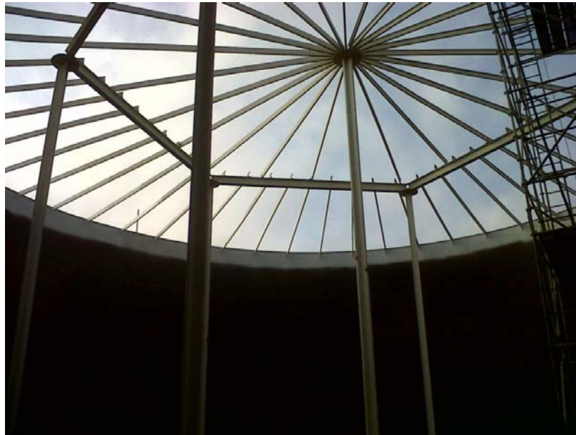
Figura 23: Tanque de techo soportado Fuente:(CEAzul, 2013)
