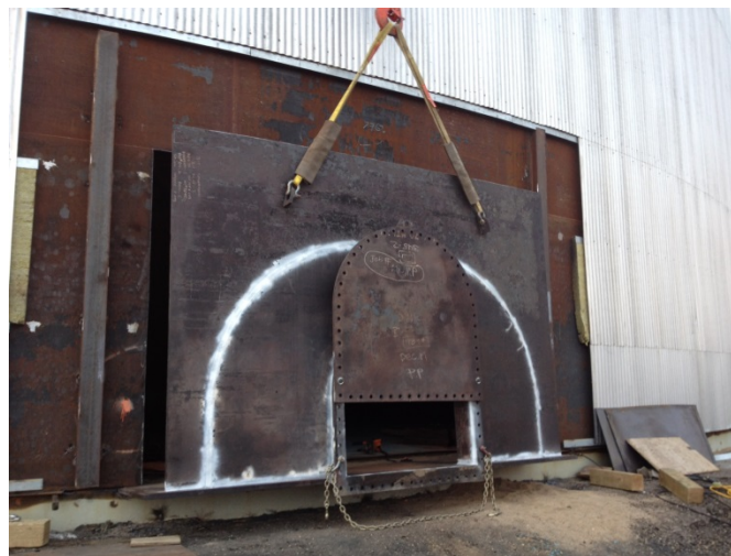
Figura 33: Puerta de Limpieza de un Tanque Atmosférico Fuente:(AGI, 2012)
