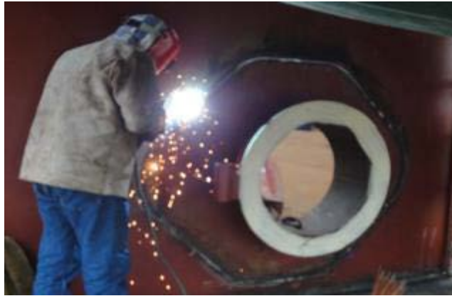
Figura 30: Manhole de un Tanque Atmosférico
