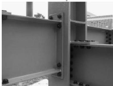
Figura 5. 24. Conexión a momento con placa extremo
