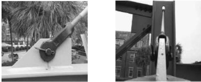
Figura 5. 36. Conexión con placa de ojo
