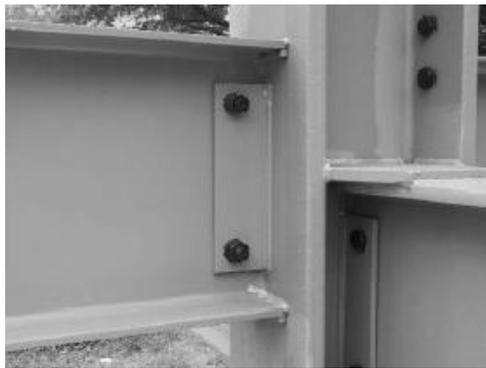
Figura 5. 18. Conexión de la viga B1
