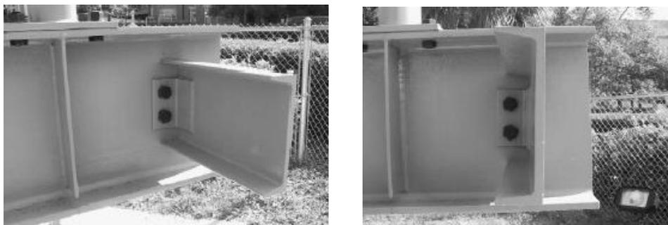
Figura 5. 29. Viga B4A y B4B conectadas a la viga B4
