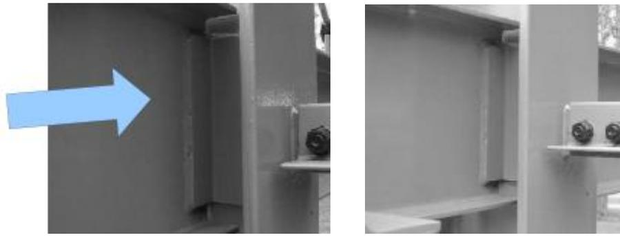
Figura 5. 40. Conexión doble angular soldada
