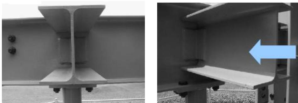
Figura 5. 41. Conexión doble angular soldada
