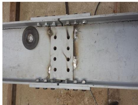
Figura 5. 10. Fijación de perfiles para traslape
