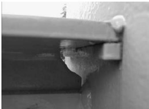
Figura 5. 19. Placas de refuerzo soldadas en la parte inferior del patín
