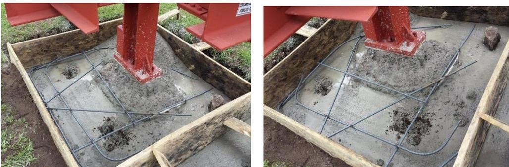
Figura 5. 43. Construcción de la placa de hormigón
