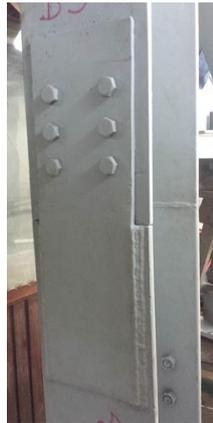
Figura 5. 16. Conexión de empalme completo
