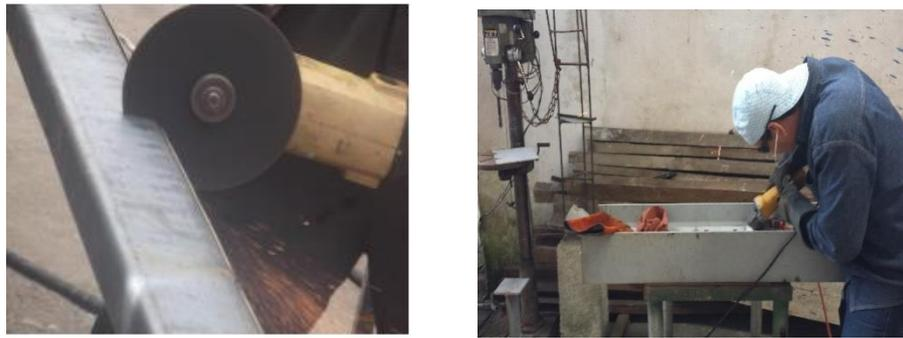
Figura 5. 12. Corte del elemento estructural
