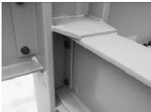
Figura 5. 28. Conexión de placa de ala soldada
