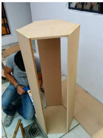
**Figura 137. Foto construcción prisma texturas.**
