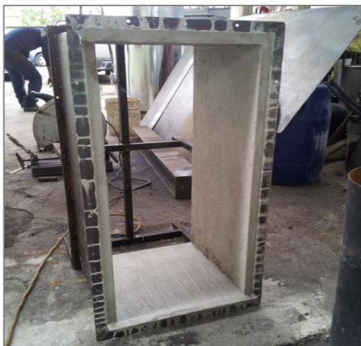
Figura 103. Fundición de cemento refractario en cámara de combustión
