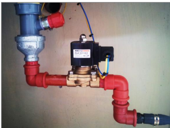
Figura 109. Instalación de electroválvula de 1/2"
