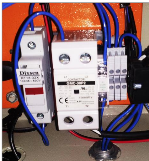
Figura 111. Instalación del control industrial en armario
