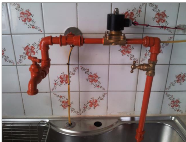
Figura 108. Instalación de electroválvula de 3/8”
