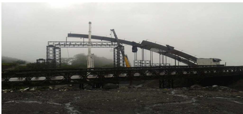
Figura 21. Montaje del Arco Puente Reventador
