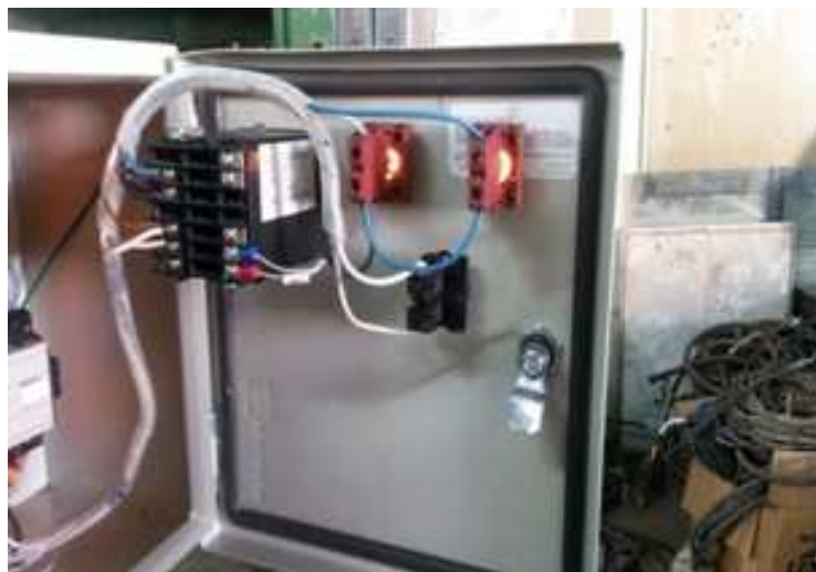
Figura 52. Circuito de Conexión del Control de Temperatura
