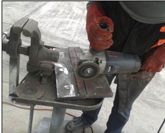
Figura. No. 43. Retiro de placa de respaldo y puentes en juntas soldadas.
