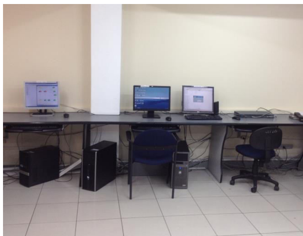
Figura 9. Computador de Gestión de Transmisiones (Marcas: SIAE, RAD y SIEMENS)
