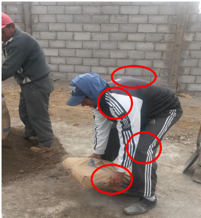
Figura Nº 25 Zonas afectadas del cargo de Albañil
