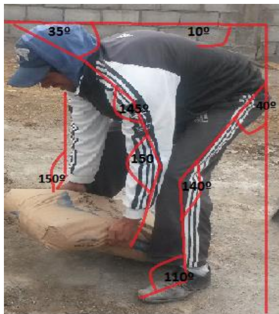
Figura Nº 4 Grados de inclinación en las posturas del cargo de Albañil
