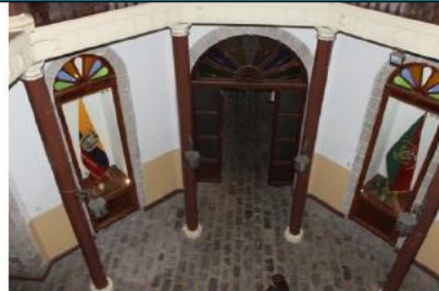
Descripción:Detalle de los pilares de madera que conforman la galería.
