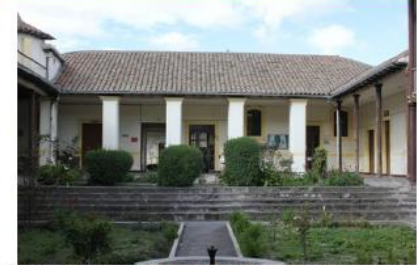
Descripción: Detalle de los elementos decorativos al interior del inmueble.
