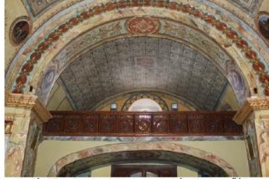
Descripción: Vista interior del coro con la bóveda de cañón corrido y su arco de soporte.
