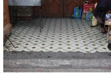
Descripción: Piso de baldosa de la iglesia, las gradas son de piedra.
