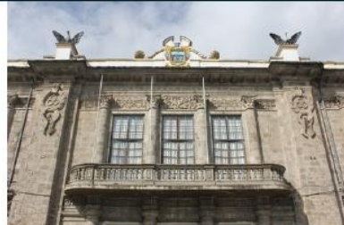
Descripción:Acercamiento de los elementos decorativos que hacen de remate de fachada.
