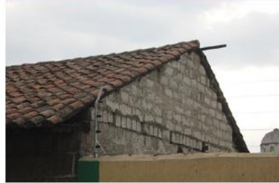
Descripción:Detalle del hastial y parte de la cubierta.
