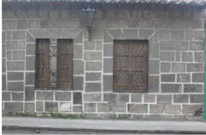
Descripción:Detalle de los elementos decorativos que se observa en la fachada.
