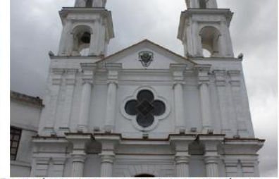
Descripción: Visual del remate de la fachada, el frontón y las torres que se ubican a los lados.
