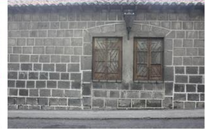
Descripción:Detalle de los vanos de ventana, algunos de ellos presentan ventanas geminadas.
