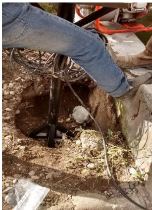
Figura 59 Realización del agujero y colocación del soporte estructural principal.
