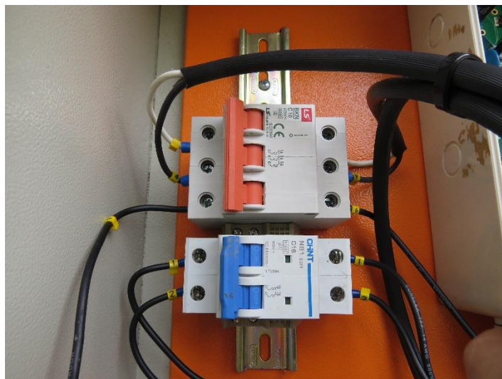
Figura 50 Interruptores de circuito modo directo y modo acumulación.
