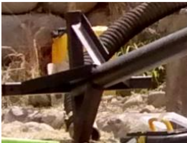
Figura 37 Base terminada de la estructura.
