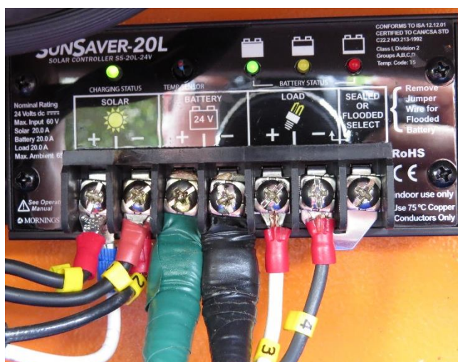
Figura 83 Conexiones al controlador de voltaje.
