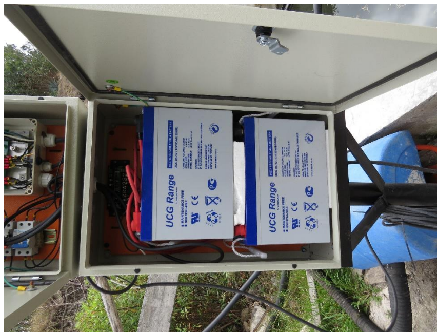
Figura 44 Conexiones del sistema de potencia.
