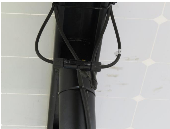
Figura 108 Conexión de celdas fotovoltaicas.
