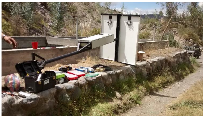
Figura 58 Colocación de cajas de control, potencia y monitoreo.
