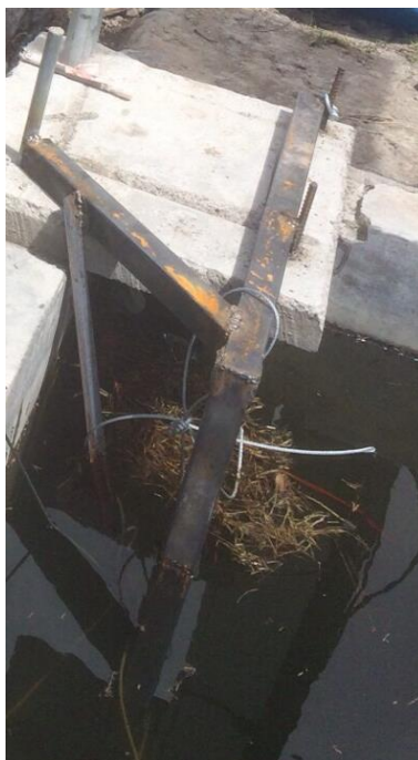
Figura 69 Brazo de sujeción para forma vertical.
