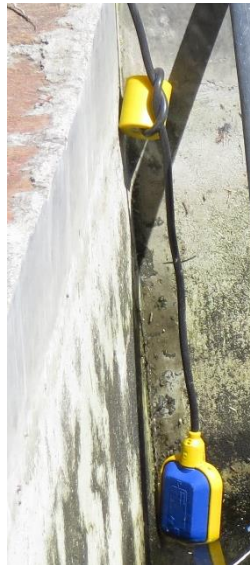
Figura 77 Componentes principales del sensor de boya.
