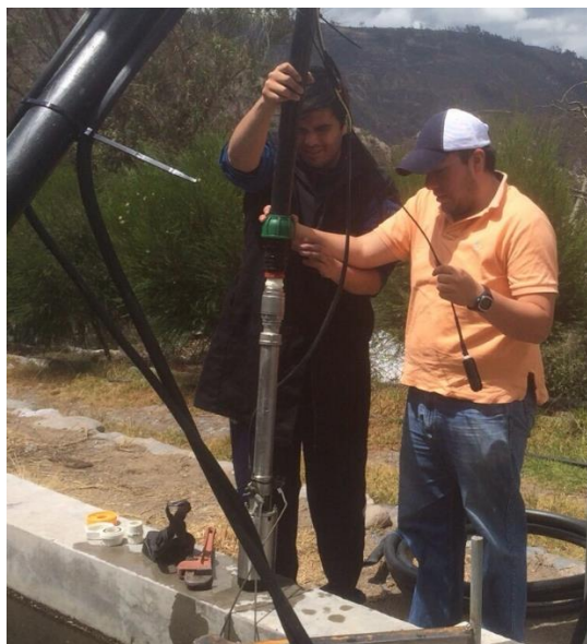
Figura 71 Aseguramiento del conector de manguera en la bomba.
