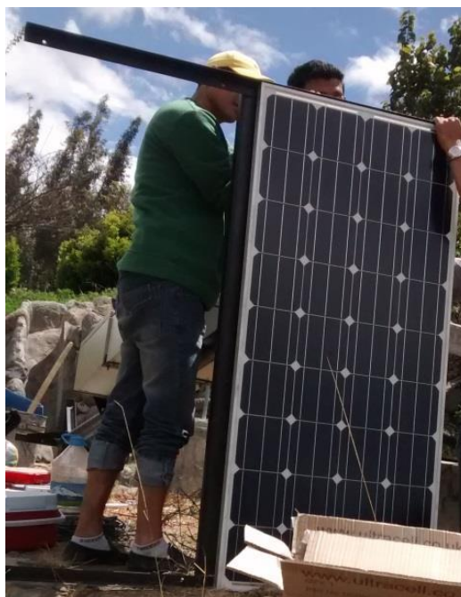
Figura 40 Base de paneles fotovoltaicos terminada.
