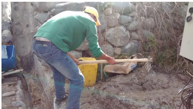
Figura 60 Colocación de concreto en el agujero realizado.
