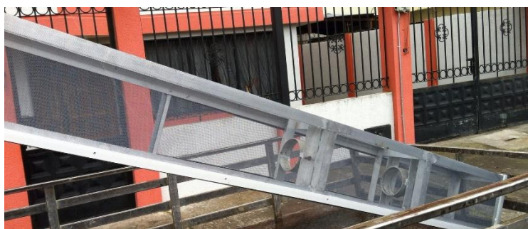
Figura 67 Estructura de la jaula terminada para la bomba.
