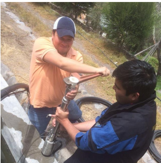
Figura 70 Montaje de juntas del sistema de bombeo.
