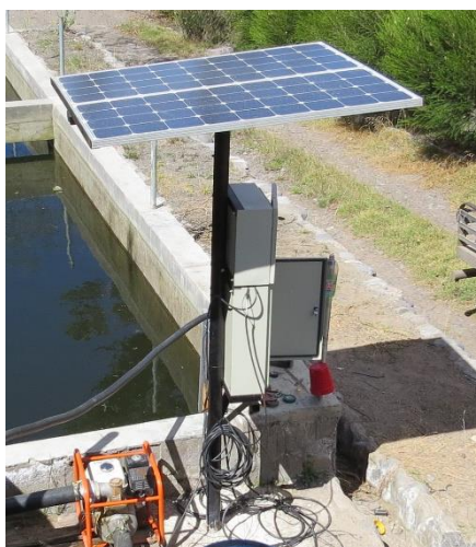
Figura 61 Aseguramiento final del soporte estructural.
