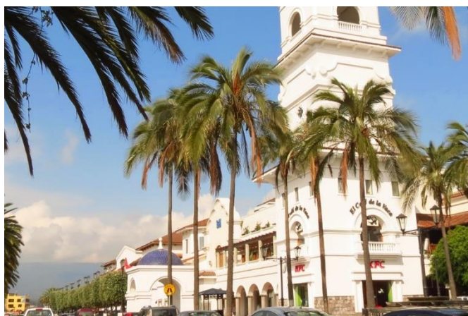
Figura 145: Centro comercial San Luis
