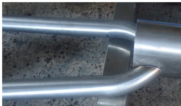
Figura 111: Tubería de 1’ con dobles
