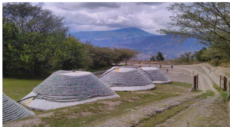
Figura 1 Campo de colectores parabólicos en Tunas y Cabras
