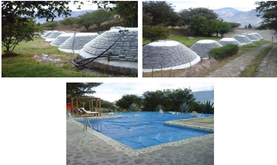
Figura 17 Calentador solar parabólico con tubos en espiral y piscina
