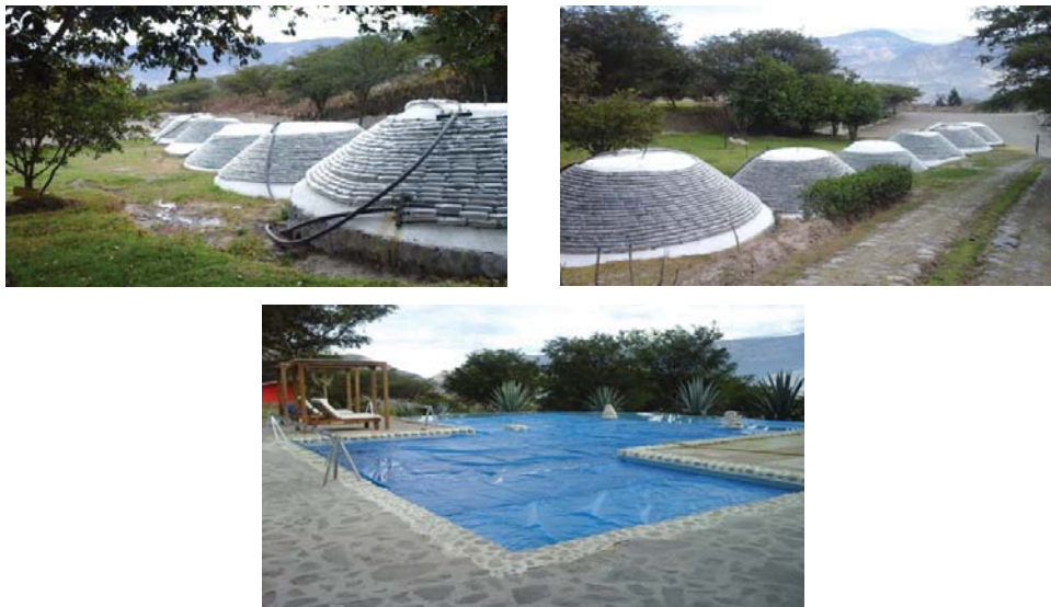
Figura 14 Calentador solar parabólico con tubos en espiral y piscina
