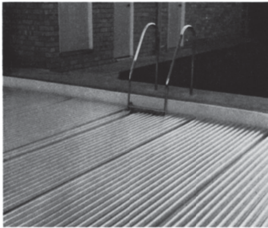
Figura 7 Piscina con calentador de tubos de polietileno
