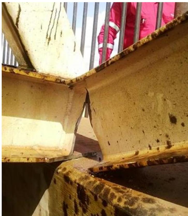
**Figura 3: Falla en la viga de anclaje**
