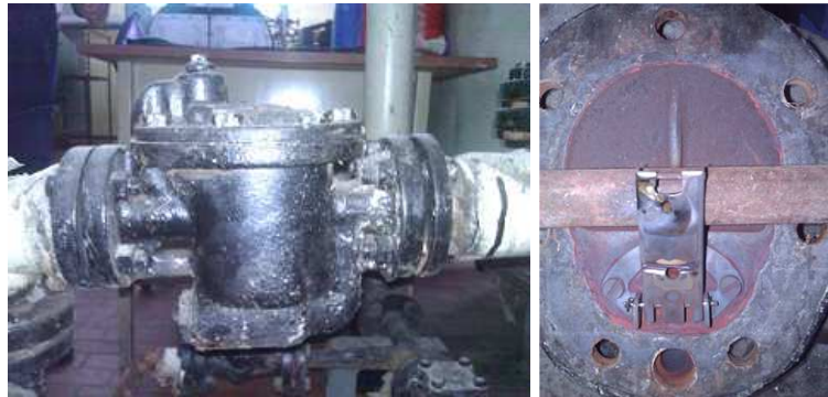
Figura 57 Evaluación y reparación de trampa de vapor
