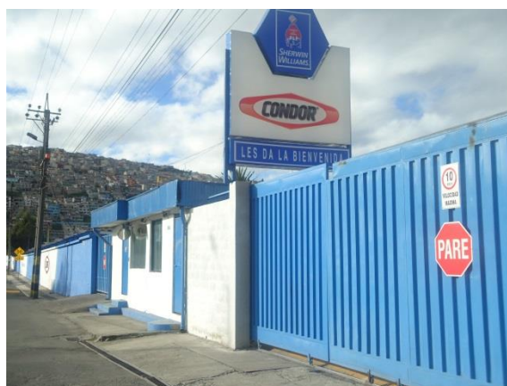
Figura 1 Planta Pinturas Condor
