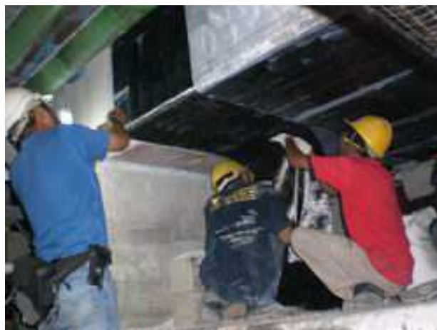
Figura 5. Colocación de tejidos F.R.P.
