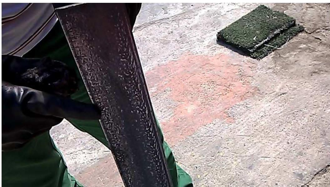
Figura 37. Superficie libre de impurezas y lista para ser reforzada
