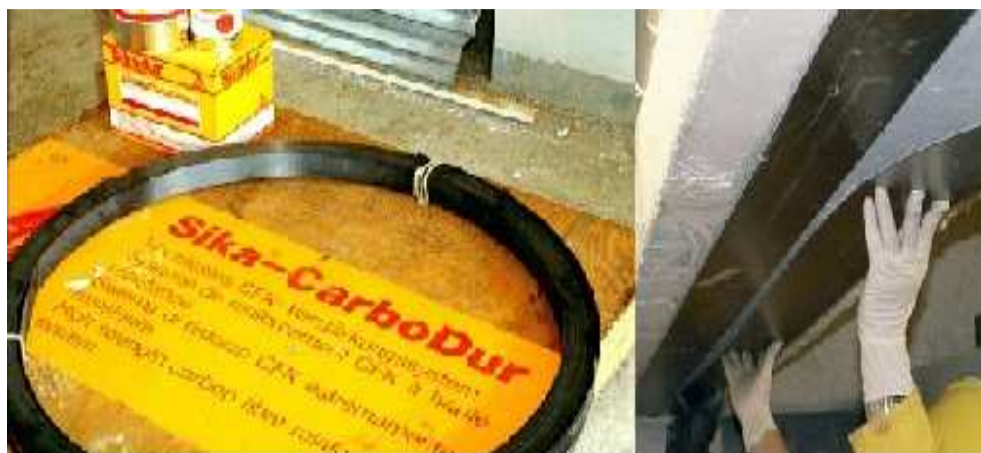
Figura 7. Platinas FRP y resina SikaDur 330
