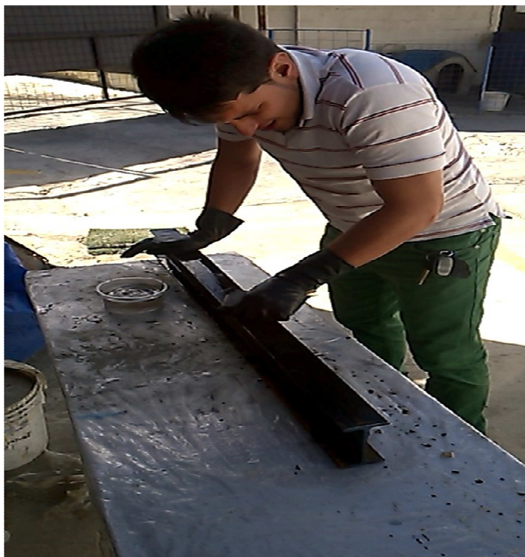
Figura 36. Limpieza de la cara que se reforzara con FRP
