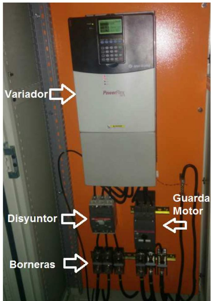
**Figura 48. Tablero de Potencia**
