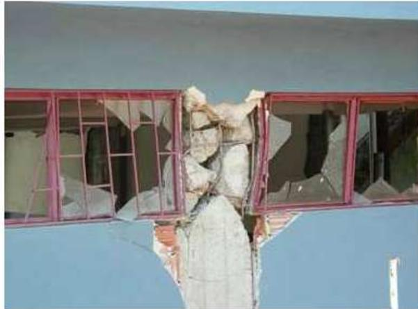
*Figura 3-20. Falla por columna corta*
