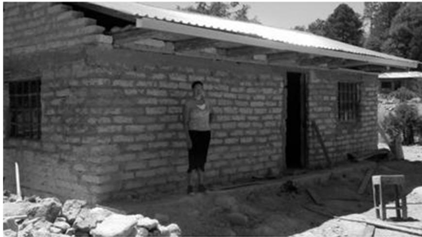
*Figura 3-29. Vivienda de mampostería no reforzada bajo el sistema "Auto-construcción"*
