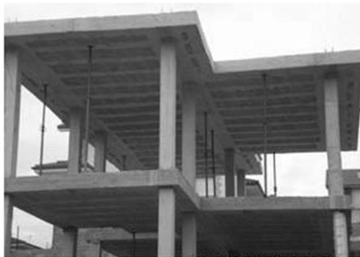
*Figura 3-1. Estructura a base de pórticos*
