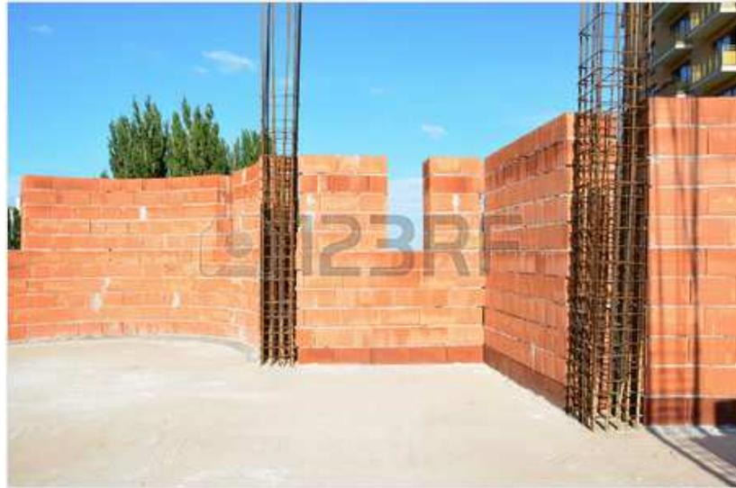
*Figura 3-31. Construcción de vivienda con mampostería confinada.*
