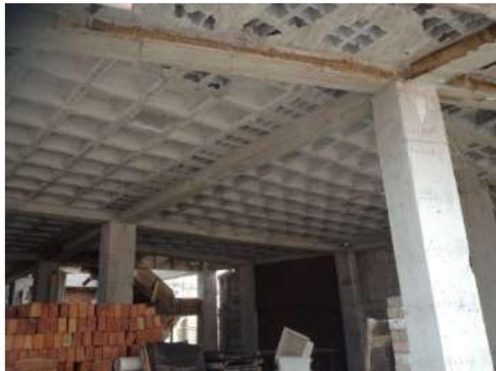
**Figura 25:** Detalle construcción aporricada (columnas, vigas descolgadas y losa alivianada).
