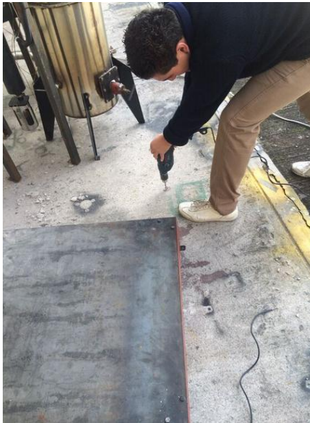
Perforación de pernos de anclaje
