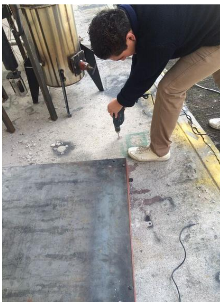
Figura 23. Perforación de pernos de anclaje
