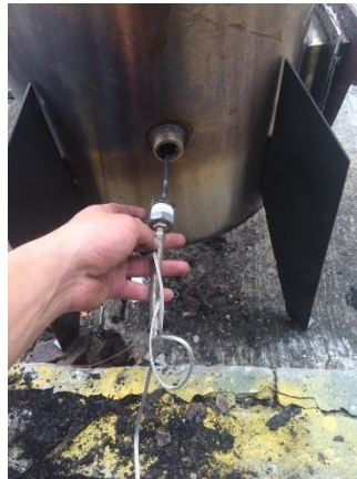
Figura 26. Instalación de termocuplas
