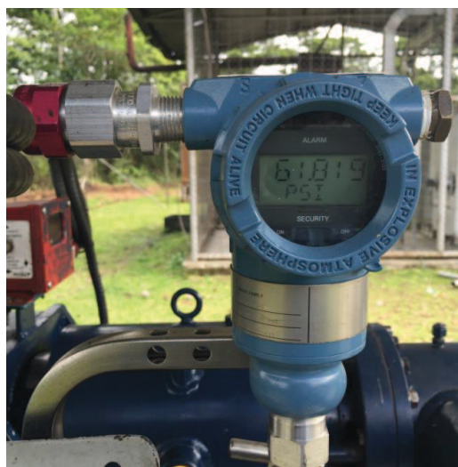
Figura 46: Funcionamiento del transmisor de presión PIT_201A
