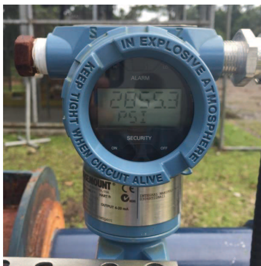
Figura 48: Funcionamiento del Transmisor de presión PIT_201B
