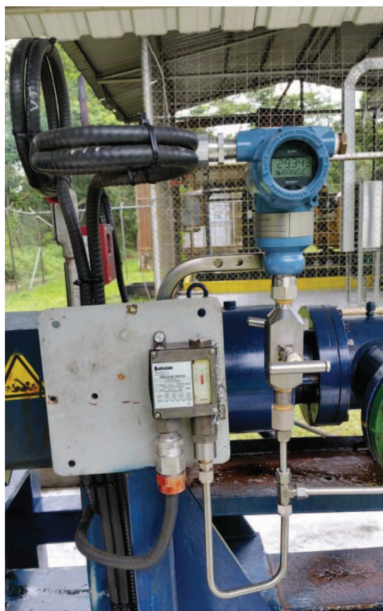
Figura 34: Sistema de protecciones en la succión
