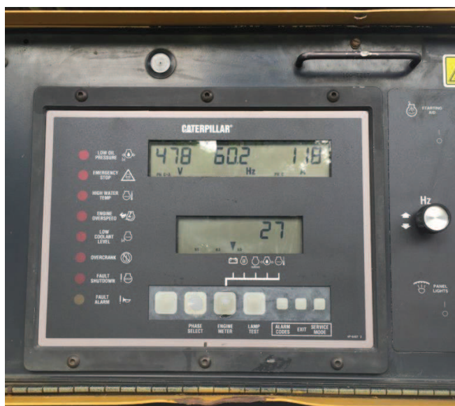
Figura 28: Pantalla de Controlador EMCP4
