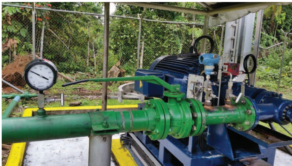
Figura 33: Sistema de protecciones en la succión
