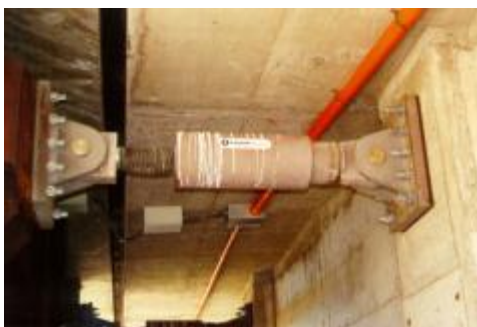
Figura 7 Disipador de Energía
