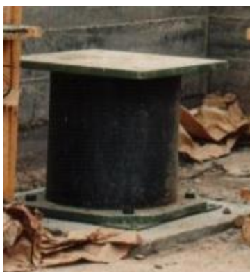
Figura 6 Aislador Sísmico de goma
