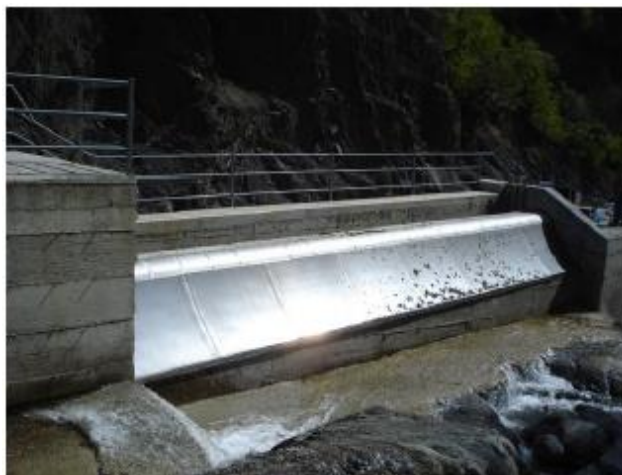
Fotografía 2.6: Obra terminada de una obra de captación con pantalla que emplea el efecto Coanda.
