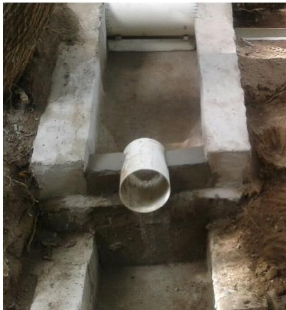
Fotografía 4.6: Canal de descarga.
