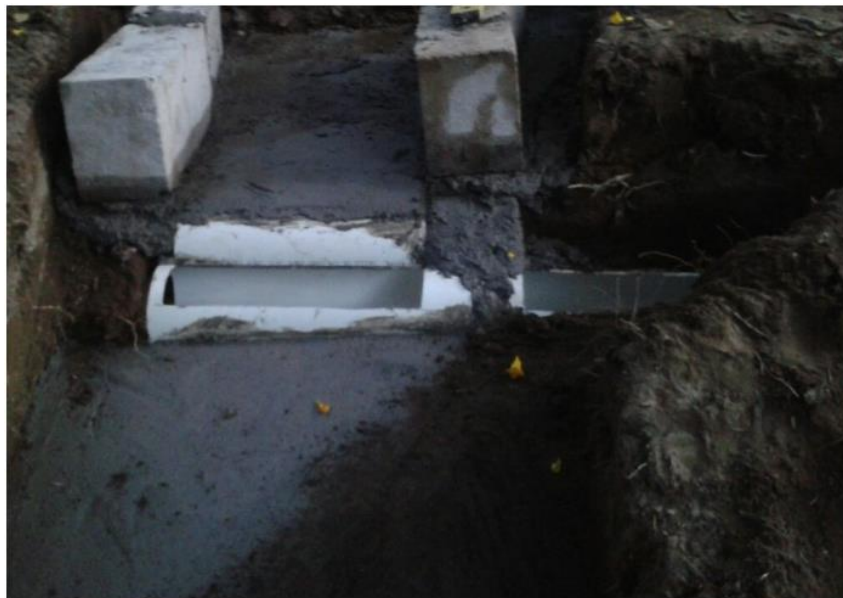
Fotografía 4.19: Colocación del canal de recolección.
