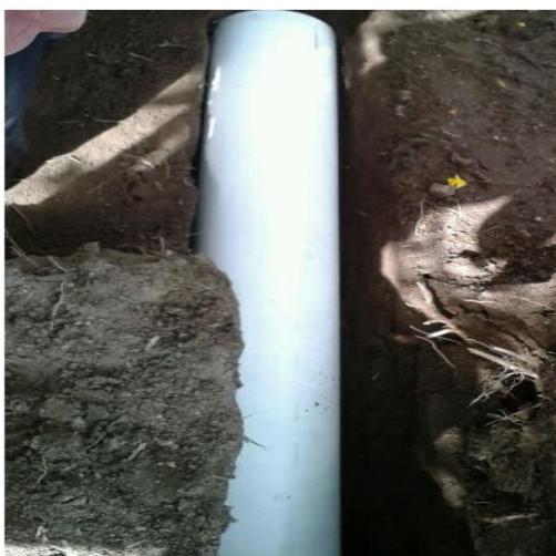
Fotografía 4.11: Tubo PVC liso de 150 mm de diámetro para el canal recolector.
