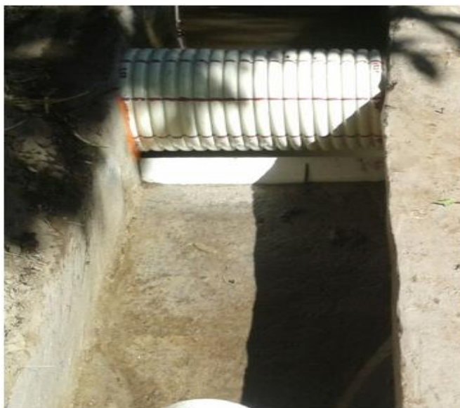
Fotografía 4.21: Colocación tubo PVC corrugado.
