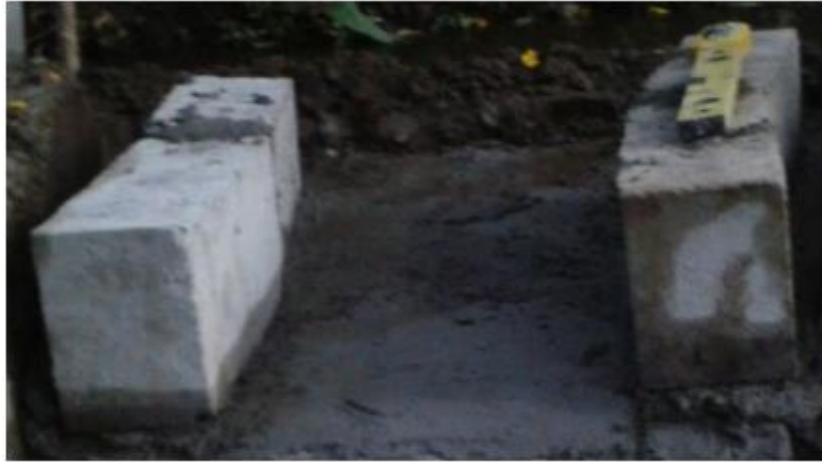
Fotografía 4.18: Colocación de bloques.
