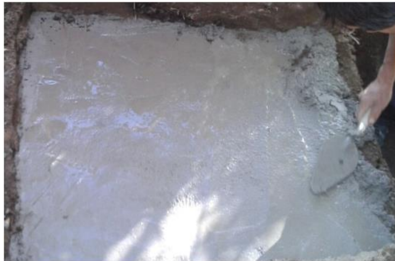
Fotografía 4.17: Revestimiento al canal de acercamiento.
