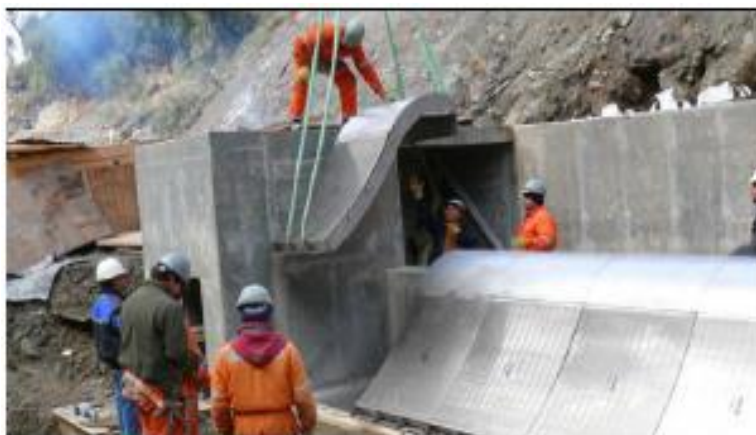
Fotografía 2.4: Proceso de colocación de una malla autolimpiante.
