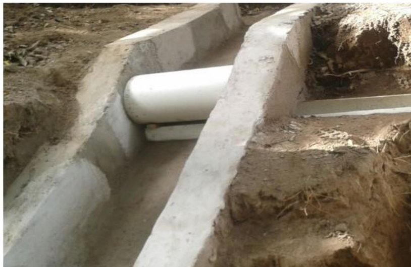
Fotografía 4.20: Colocación tubo PVC liso.
