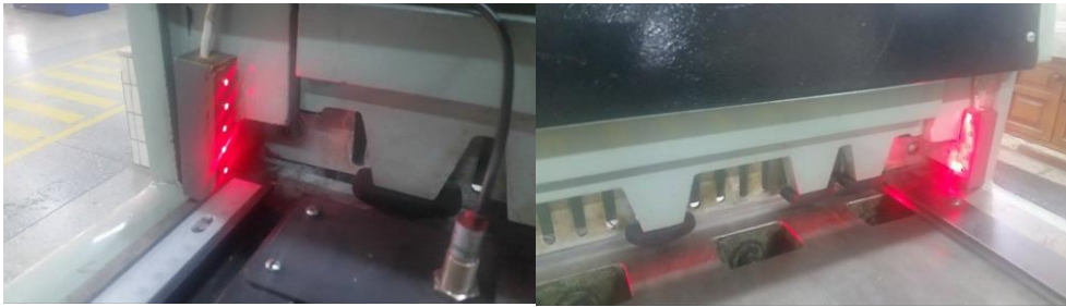
Figura 115. Sensores Laser en funcionamiento.
