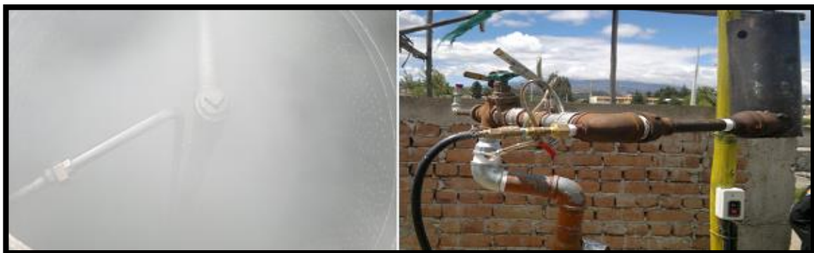
Figura No. 23 Succión del gas por efecto Venturi
