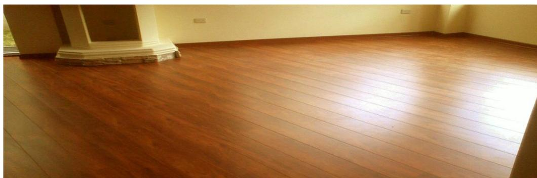
**Figura # 28:** Piso con Hidrolaqueado
