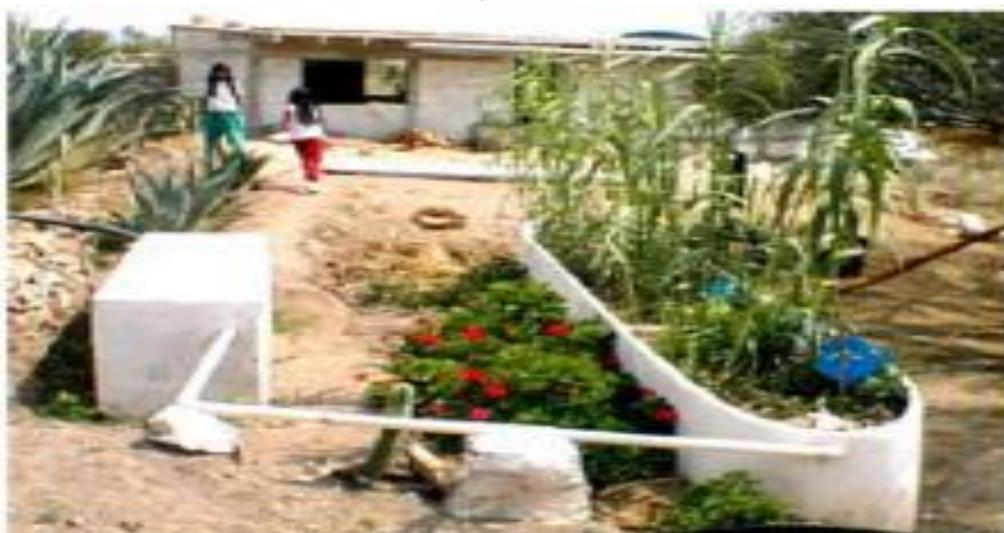
**Figura # 45:** Tratamiento de aguas mediante fosas y biofiltro
