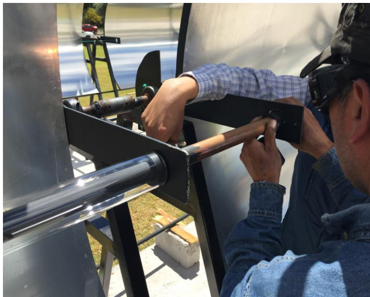
Figura 107. Colocación del acople de grilón en los concentradores.
