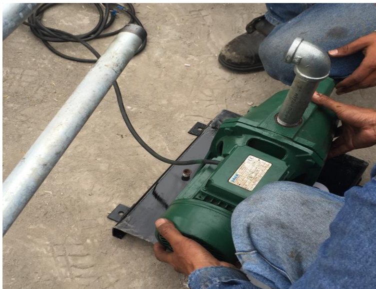
Figura 119. Instalación de la bomba centrífuga para aceite térmico.
