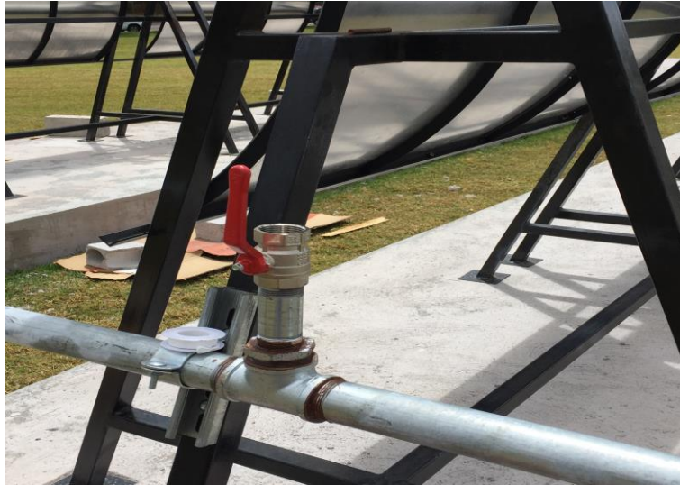
Figura 116. Instalación de las válvulas esféricas sobre los CCP.
