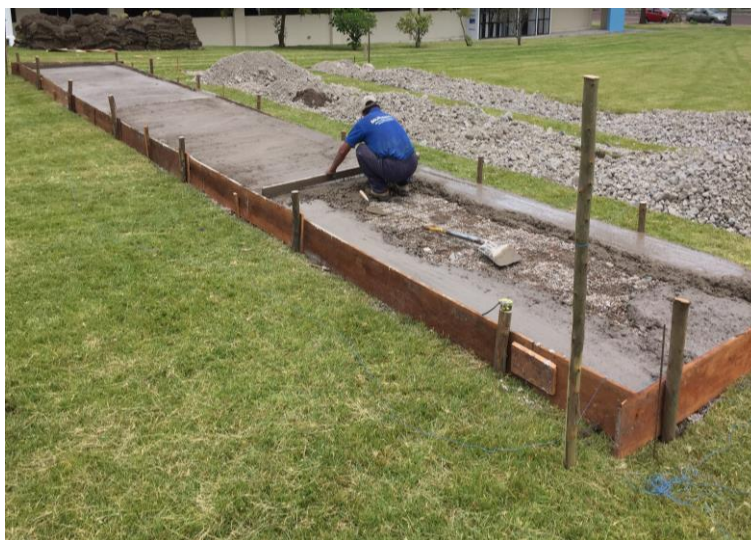
Figura 92. Mezcla de materiales para la fundición del hormigón.
