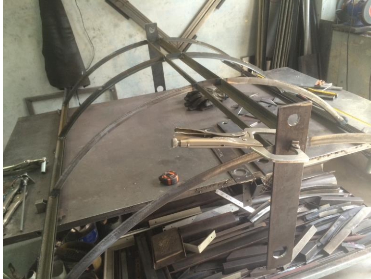
Figura 77. Soldado de piezas de la estructura de la lámina de aluminio.
