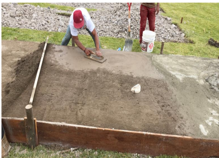
Figura 93. Alisamiento de los bordillos donde se ubicaran los colectores.
