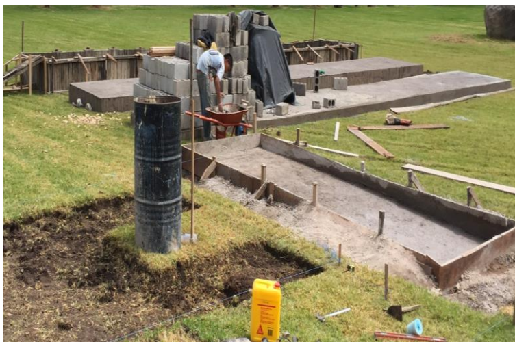
Figura 94. Secado del hormigón de los bordillos.
