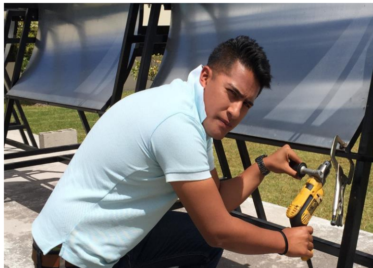
Figura 103. Perforación de los perfiles tipo L.
