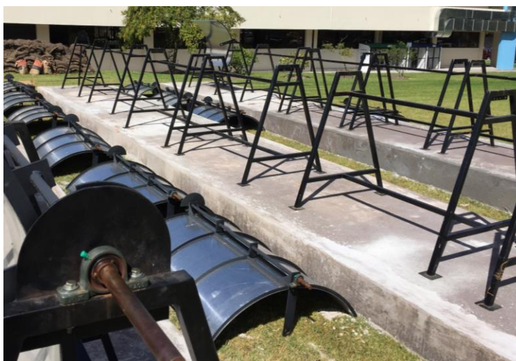
Figura 95. Ubicación de las estructuras bases de los concentradores.
