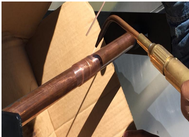
Figura 109. Unión de los tubos de cobre por medio de acoples.
