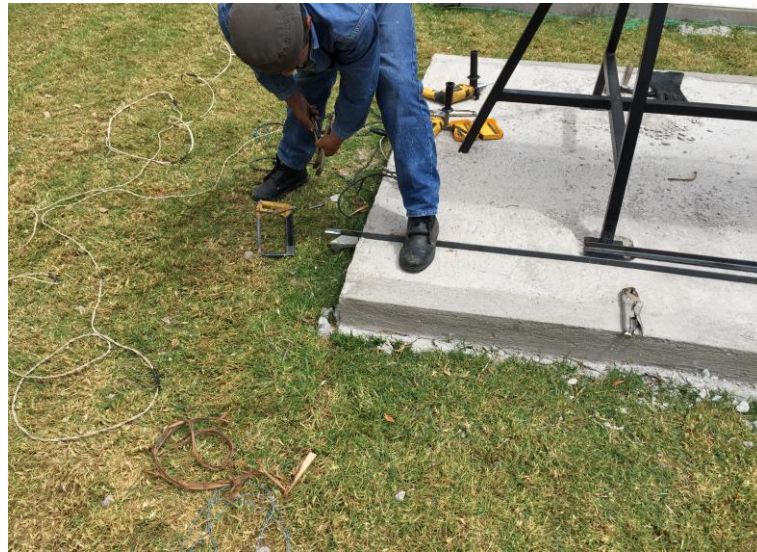
Figura 102. Soldado y cortado de los perfiles tipo L de 25 x 25 x 4 mm.
