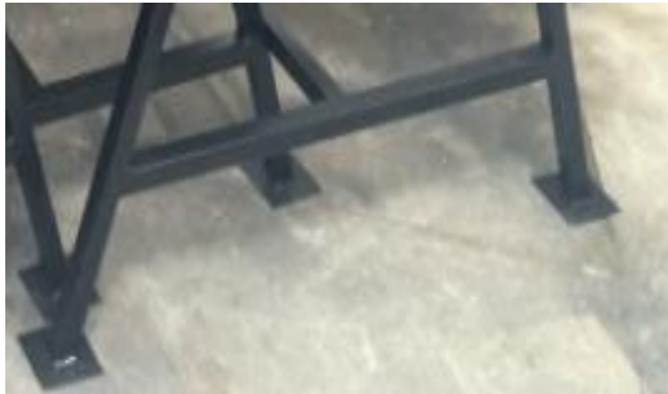
Figura 76. Soldado de platinas en las patas de la estructura base.
