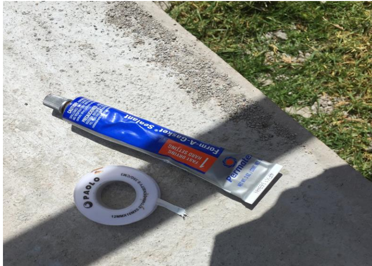
Figura 114. Sellado de los accesorios de la tubería galvanizada.
