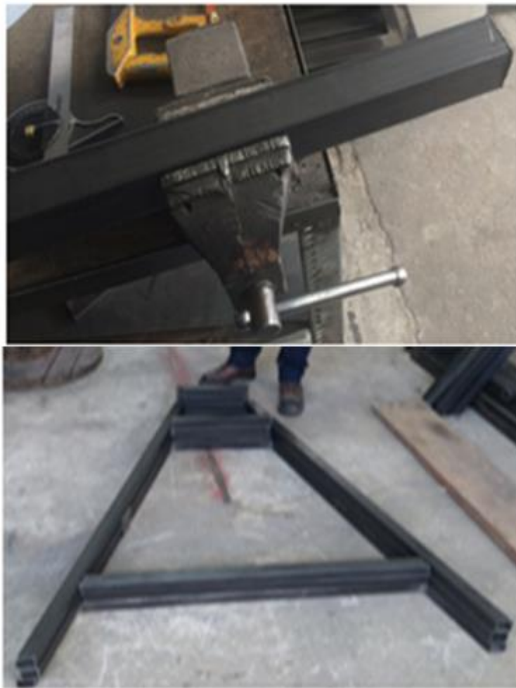
Figura 73. Tubos cuadrados biselados listos para soldar.
