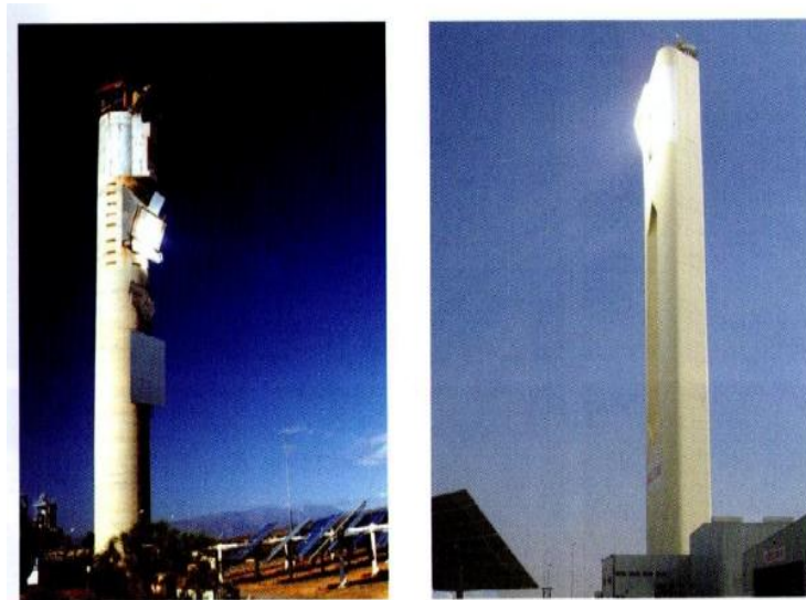
Figura 10. Plataforma Solar Almería y torre de la PS 10.
