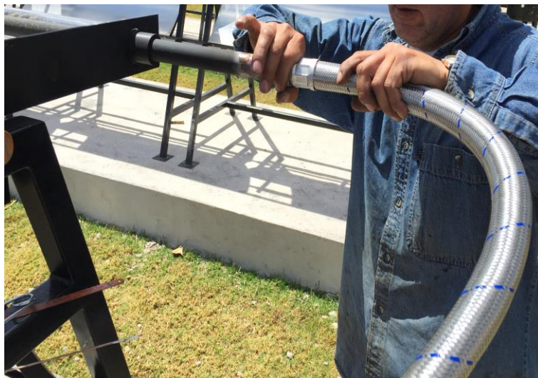
Figura 117. Instalación de las mangueras hidráulicas.
