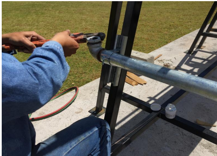
Figura 115. Colocación de accesorios en la tubería galvanizada.
