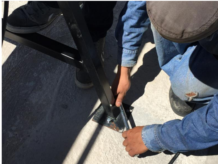
Figura 99. Colocación de los tirafondos sobre los tacos fischer.
