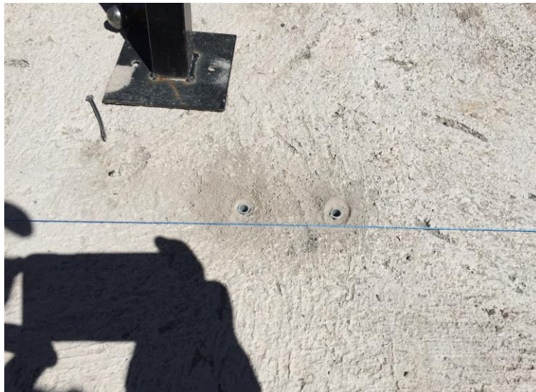
Figura 98. Colocación de los tacos fischer sobre las perforaciones.
