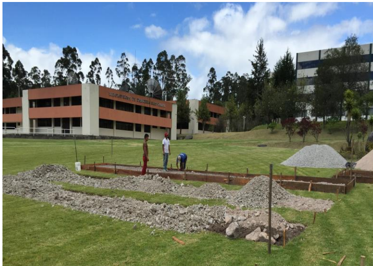
Figura 90. Encofrado de madera para rellenarlo con lastre.
