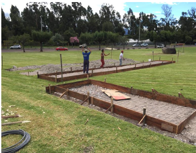
Figura 91. Refuerzo de la cimentación con la malla electrosoldada.
