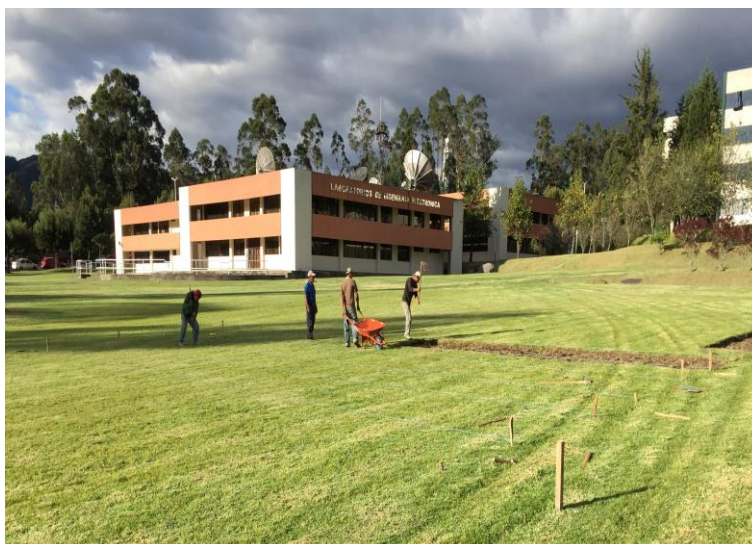
Figura 89. Corte de la hierba para poder cimentar los espacios limitados.
