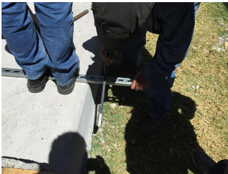
Figura 110. Cortado de las rieles de longitud 20 centímetros.
