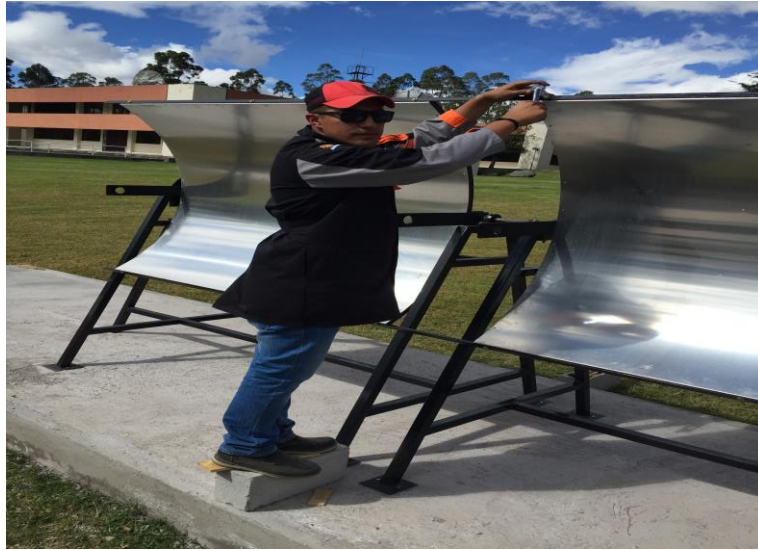
Figura 104. Ubicación de los pernos en los agujeros del perfil tipo L.
