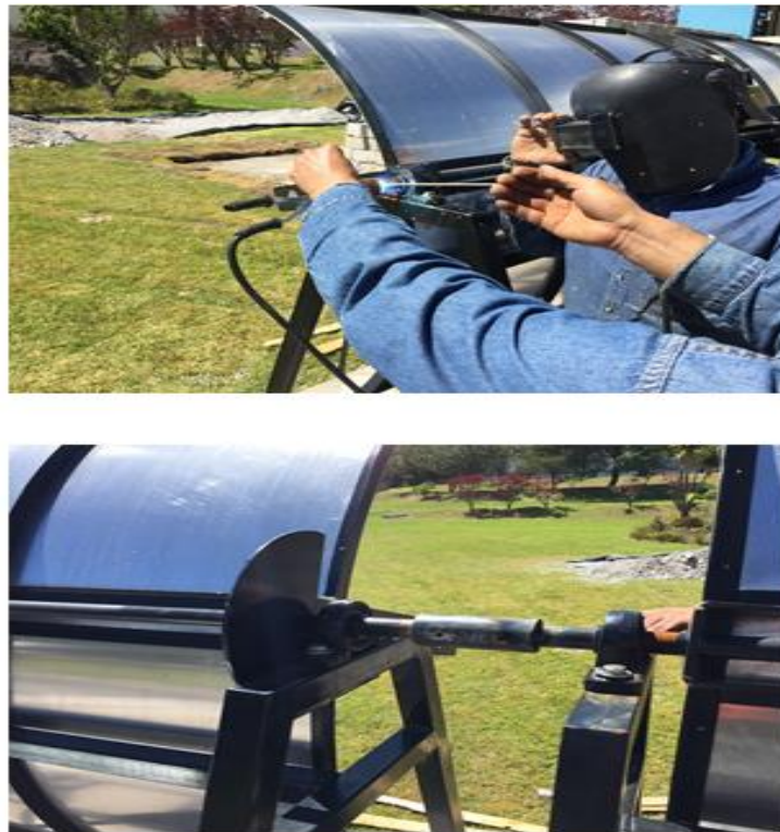
Figura 100. Soldado de los matrimonios para unir los ejes de los CCP.
