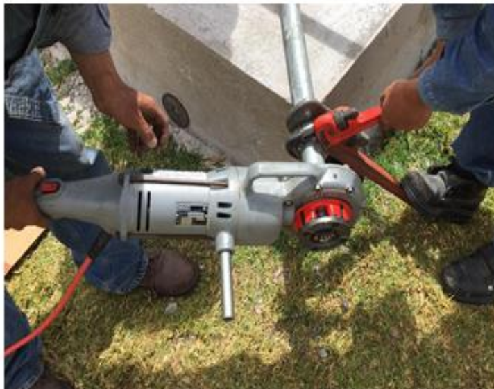
Figura 118. Roscado de la tubería de acero galvanizado.
