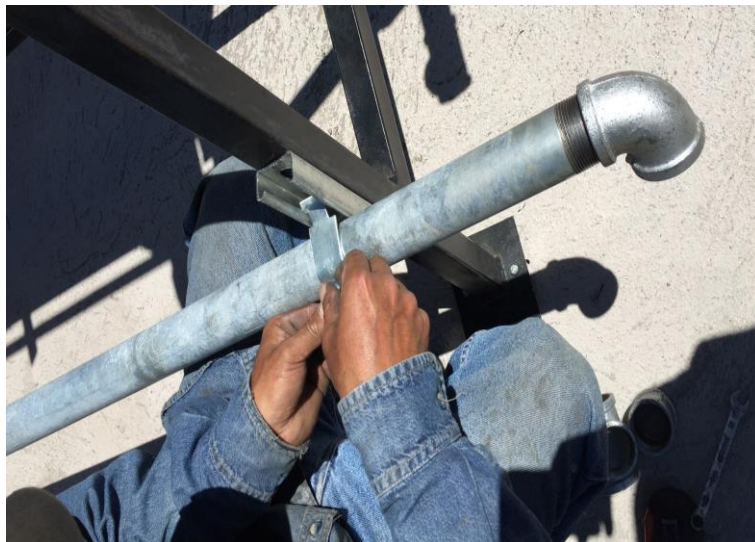
Figura 113. Sujetación de la tubería de acero galvanizado.
