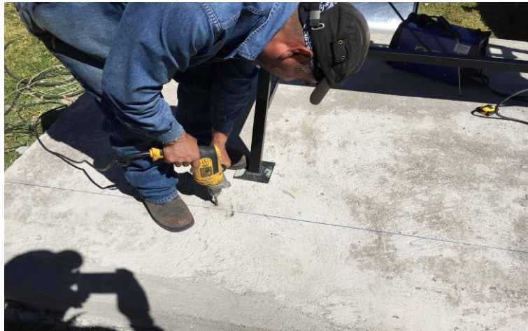
Figura 97. Alineado y perforación de las estructuras base.
