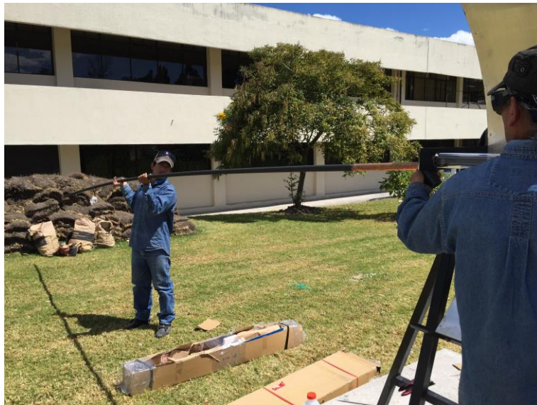
Figura 105. Montaje del tubo de cobre sobre el bocón y el tubo de vidrio.
