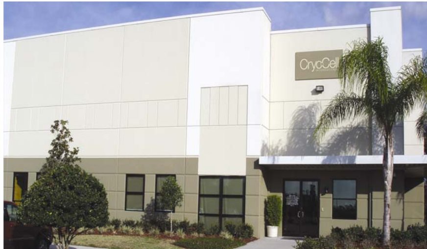
Figura 20. Infraestructura del laboratorio
