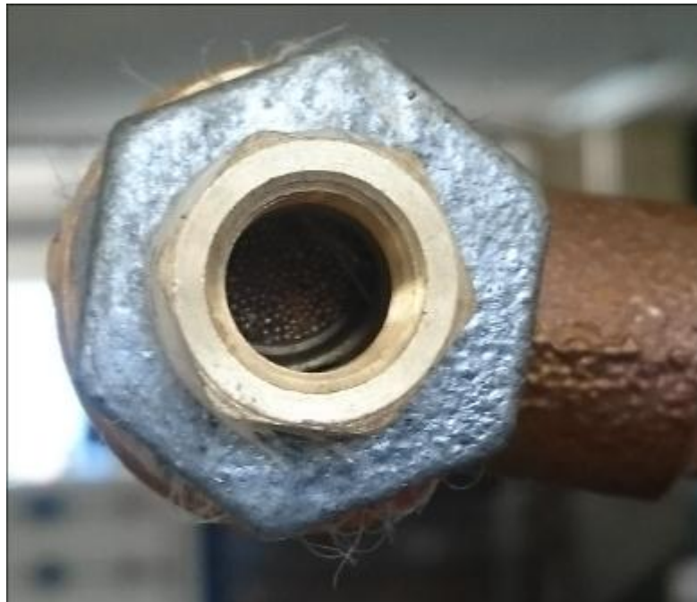
Figura 38 Incorporación de un Filtro a la Tubería del Sensor Electrónico
