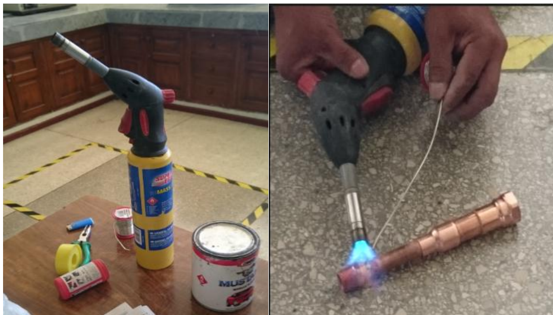
Figura 36 Componentes para Soldar la Tubería
