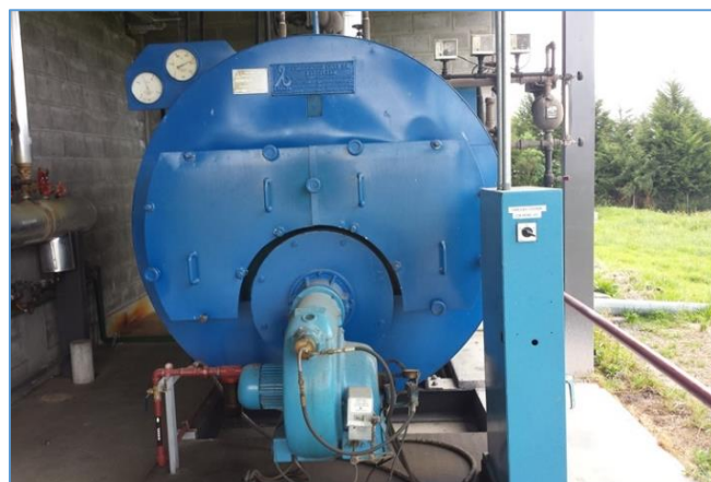
Figura 2-15 Caldero de la planta de tinturado
