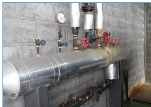
Figura 2-17 Distribuidor de vapor
