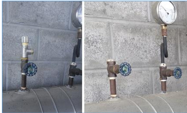
Figura 4-15 Instalación de una T para conectar el sensor de temperatura
