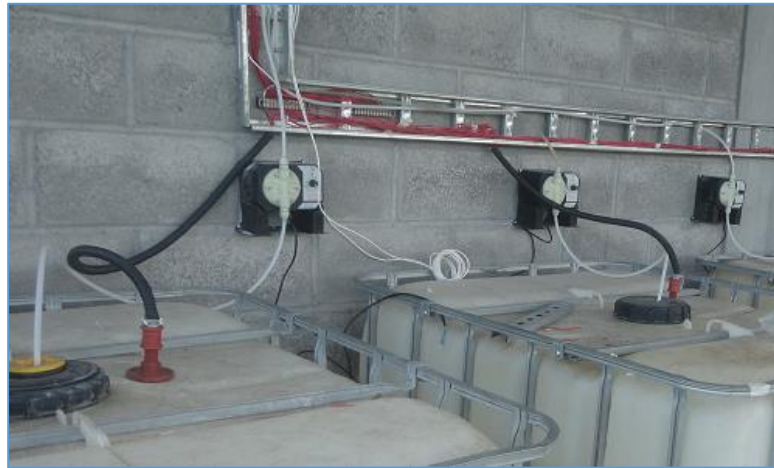
Figura 4-20 Instalación de bombas dosificadoras de químicos para el tratamiento de aguas residuales
