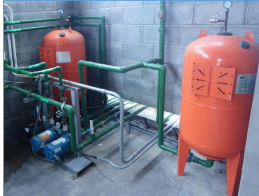
Figura 2-8 Tanques de contacto con oxígeno
