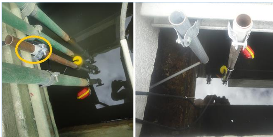
Figura 4-14 Montaje de los sensores de nivel para las cisternas
