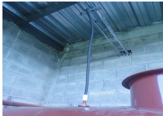
Figura 4-11 Instalación de los sensores de nivel para el tanque principal de diésel
