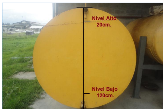
Figura 2-22 Niveles del tanque principal de diésel
