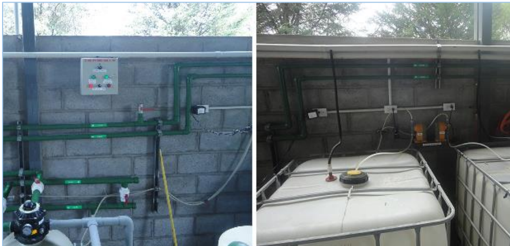
Figura 4-22 Montaje de nuevo conducto de cableado
