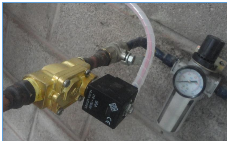
Figura 4-19 Montaje de la electroválvula para el tratamiento de aguas residuales
