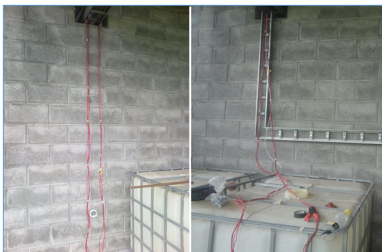
Figura 4-1 Montaje de canaletas en el área de generación de vapor
