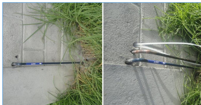
Figura 4-12 Instalación de tubo de cobre para el cableado del sensor de nivel
