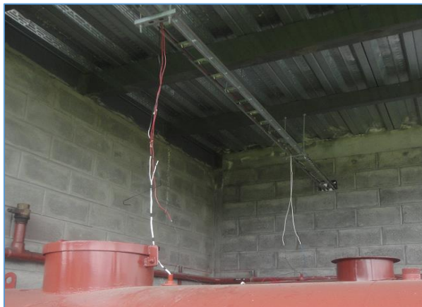
Figura 4-3 Montaje de canaleta para tendido de cable hasta los tanques de diésel
