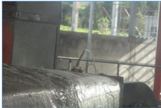
Figura 4-17 Instalación del sensor de temperatura para la cámara de secado
