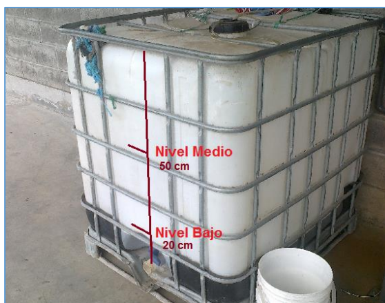
Figura 2-21 Tanque de químico
