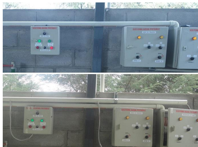
Figura 4-23 Conexión del cableado hacia los tableros de control
