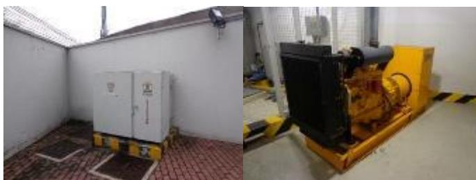
**Figura 23.** Transformador y Generador
