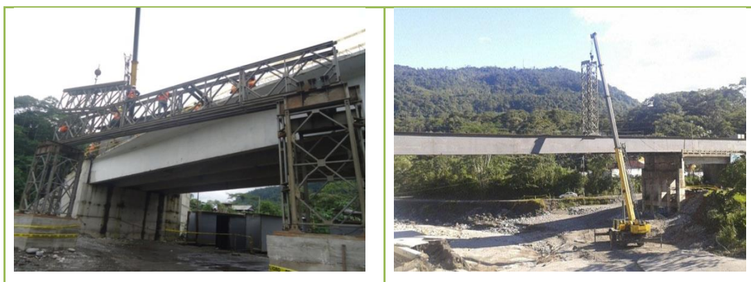
Figura 5. Fotografías obra falsa para puente Aguarico
