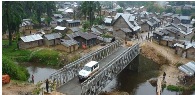
Figura 16. Imagen del Puente Acrow
