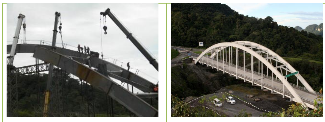
Figura 3. Fotografías obra falsa puente Reventador
