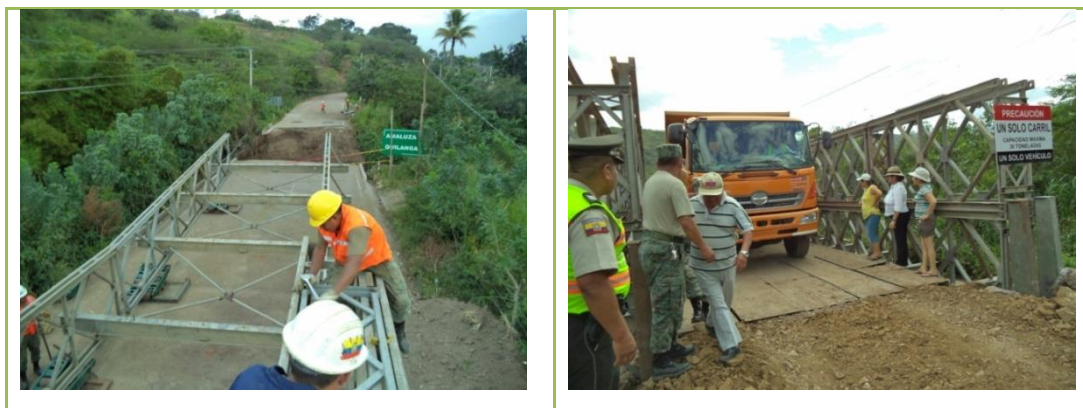
Figura 7. Fotografías montaje puente Lucero
