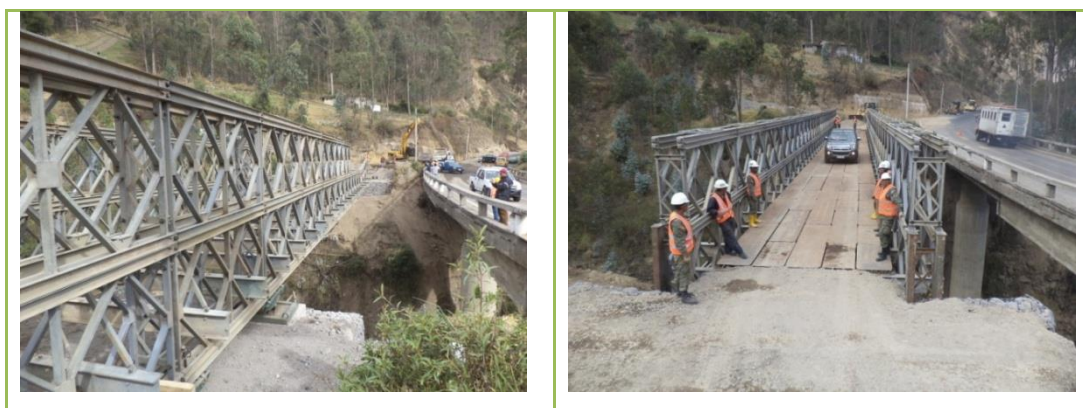
Figura 4. Fotografías montaje puente Pataló
