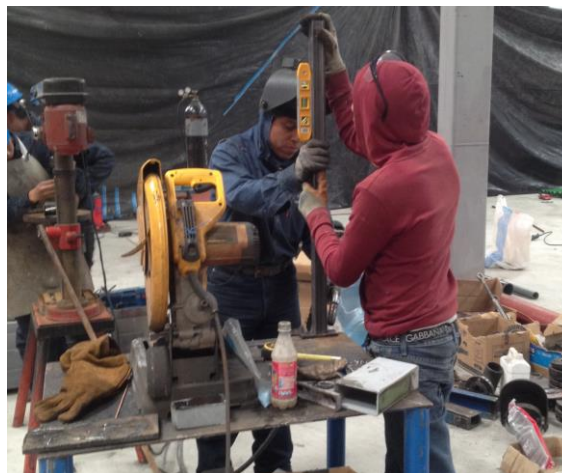
Figura 146. Construcción de placas y pasamanos
