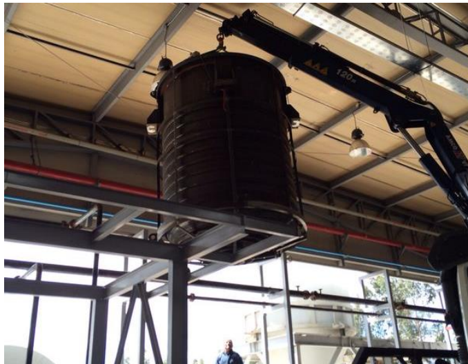
Figura 156. Posicionamiento del recipiente sobre la estructura
