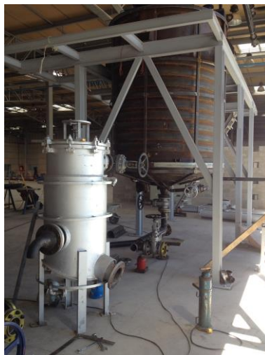
Figura 161. Montaje de tubería de premezclador
