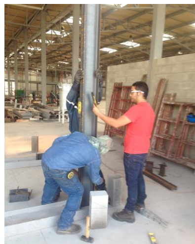
Figura 138. Cortes y Biselado de vigas y columnas
