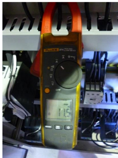
Figura 179. Medición de amperaje con pinza amperimétrica
