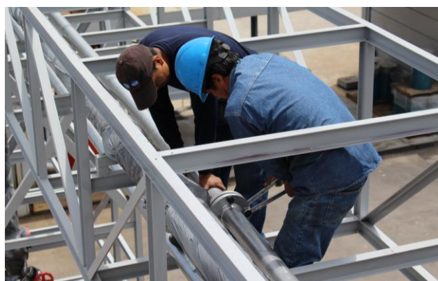
Figura 158. Montaje de tubería de aceite térmico
