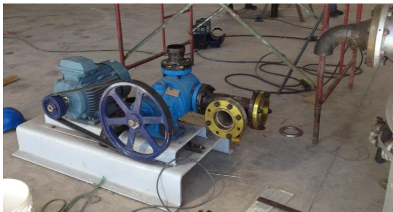
Figura 157. Instalación de bombas
