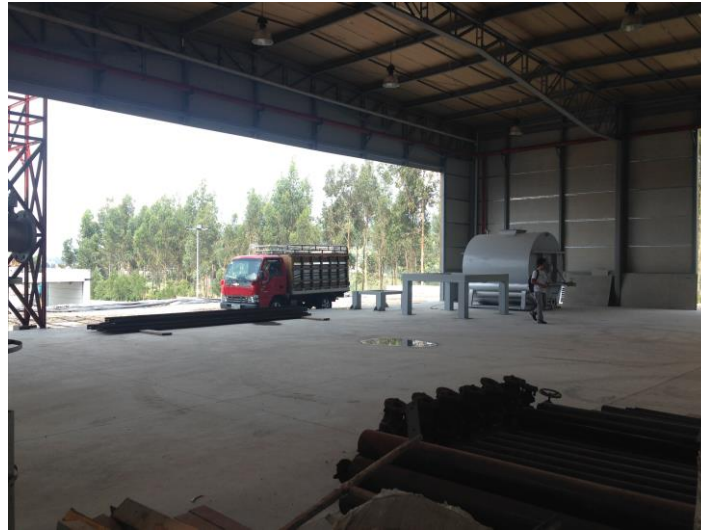
Figura 44. Lugar físico para la construcción de las estaciones de premezcla y mezcla.
