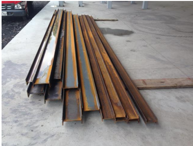
Figura 137. Perfiles IPE 200 e IPE 120 para la estructura
