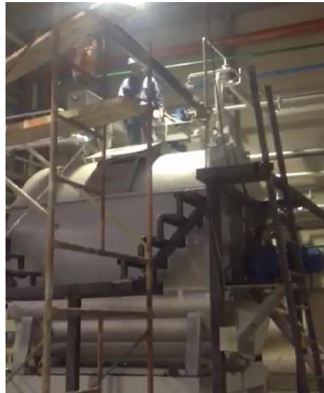
Figura 144. Montaje de largueros superiores
