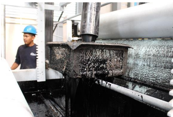
Figura 178. Llegada de asfalto modificado a la balsa de impregnación
