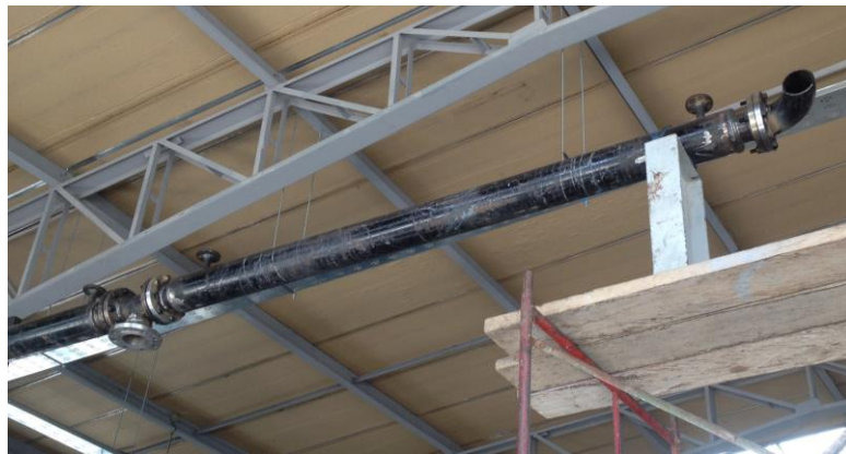
Figura 160. Montaje de tubería de asfalto polimerizado
