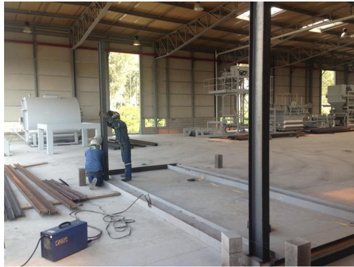
Figura 140. Columnas de soporte colocadas a medida
