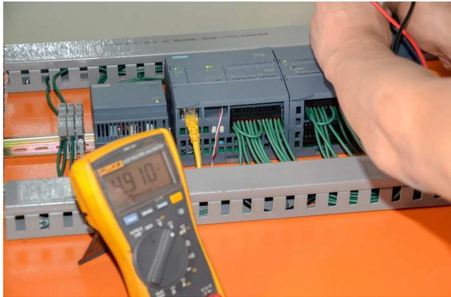
**Figura 126. Medición de voltaje para alimentación de celdas de carga**
