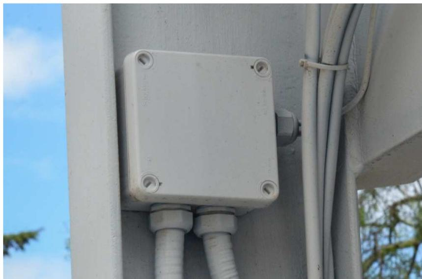
**Figura 36. Caja de conexión de celdas de carga**
