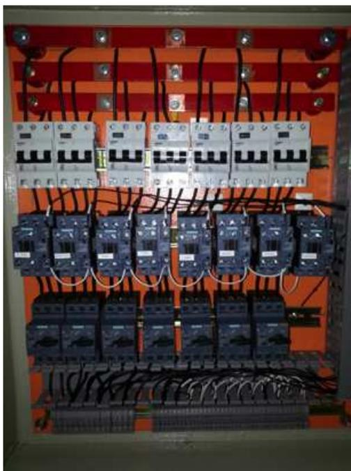
**Figura 28. Arrancadores directos en el tablero de potencia de la planta dosificadora de hormigón**
