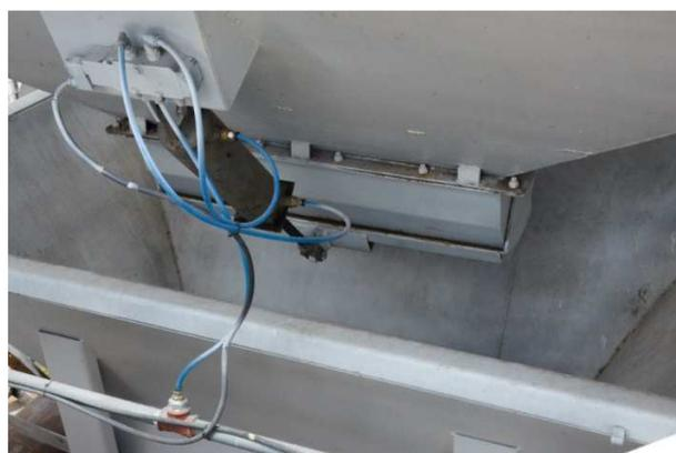
**Figura 7. Mecanismo de apertura de las tolvas de agregados**
