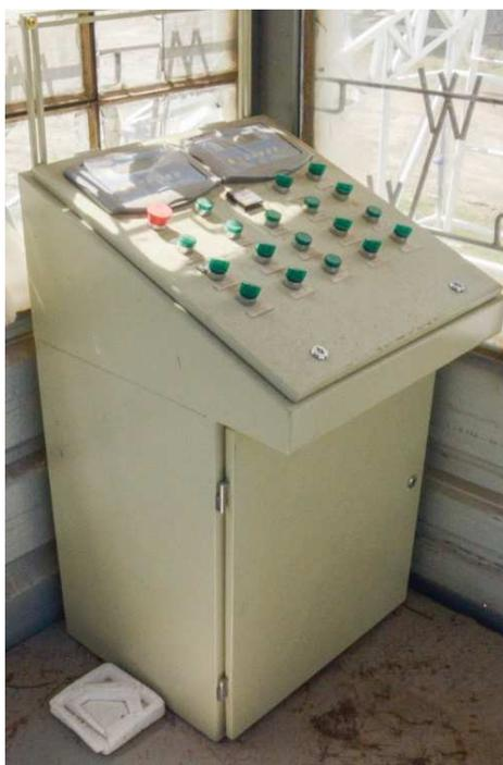
**Figura 25. Caja de mando local de la planta dosificadora de hormigón**
