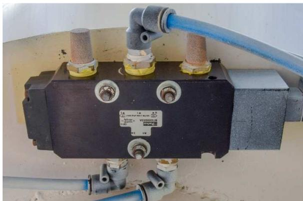
**Figura 42. Electroválvula neumática 5/2 monoestable**
