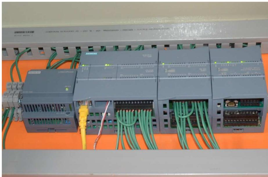
**Figura 127. Sistema de control puesto en marcha**
