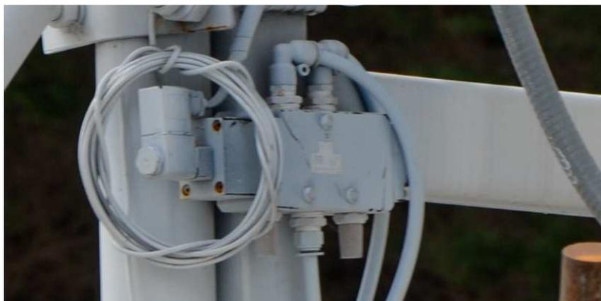
**Figura 34. Conexión de electroválvula en la planta dosificadora**
