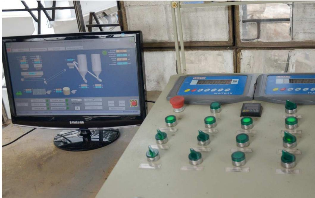
**Figura 128. Sistema de control para plantas dosificadoras de hormigón de la empresa Asphalt Plants S.A.**
