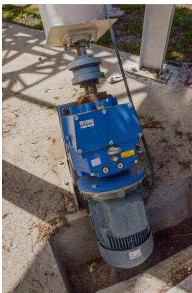
**Figura 31. Motor tornillo sin fin**
