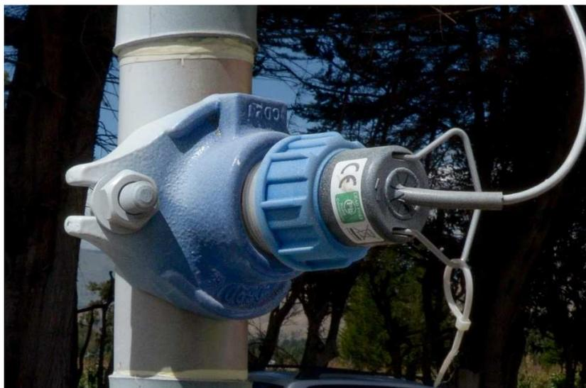
**Figura 37. Flujómetro utilizado para la dosificación de agua**
