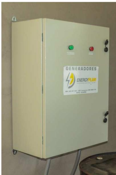
**Figura 24. Tablero del circuito de transferencia de energía**
