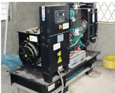
Figura 23. Generador eléctrico de la planta dosificadora de hormigón
