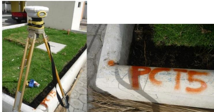
**Figura 55. Marcado de los Puntos de Control Terrestre.**
