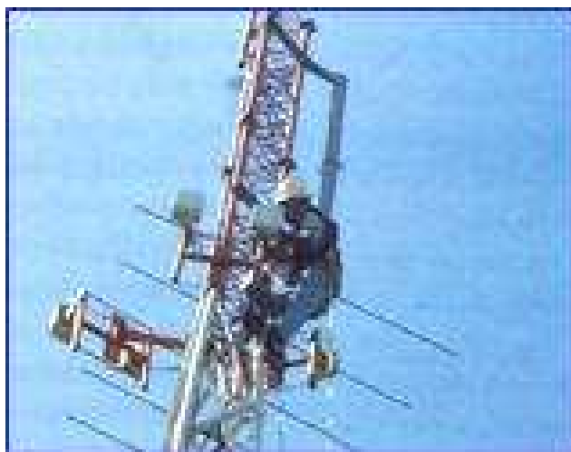
Figura 4.33 Instalación de antenas y torres de WLL
