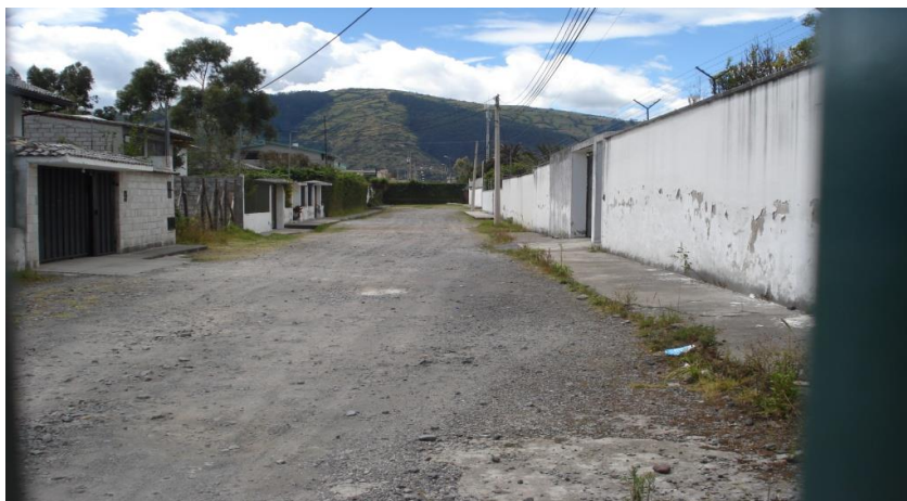
Figura 48 Vía de revestimiento suelto de mal estado, Cotogchoa, Marzo 2015. Coordenadas: Z17S, 785155mE, 9959021mS, 2646m.s.n.m.
