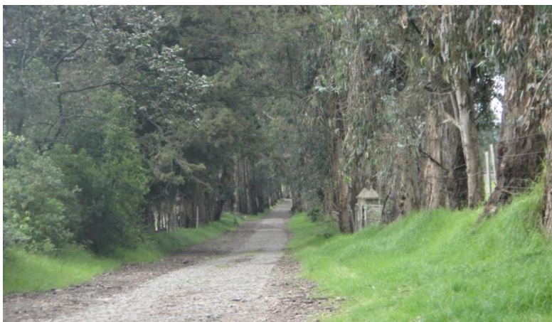
Figura 45 Vía empedrada de buen estado, Cotogchoa, Marzo 2015. Coordenadas: Z17S, 783825mE, 9957625mS, 2699m.s.n.m.
