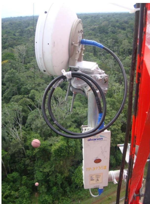
Figura 3.10 Radio Alvarion en Vinita 2
