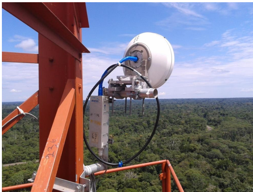
Figura 3.9 Radio Alvarion en torre Tipishca
