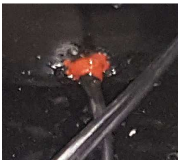
Figura 149.- Sensor de temperatura instalado.
