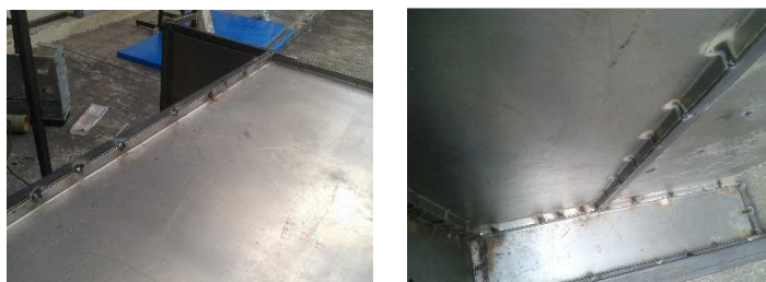
Figura 134.- Paneles soldados a la estructura
