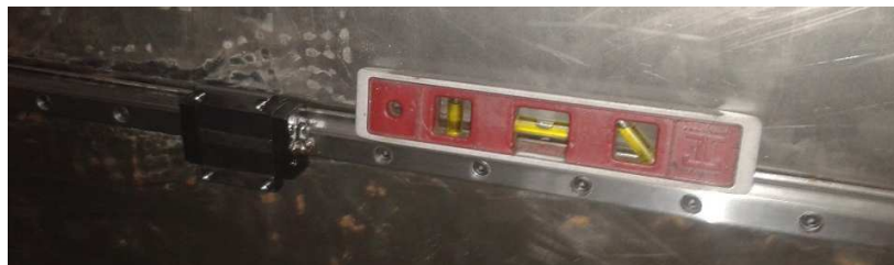
Figura 137.- Instalación de guías lineales.
