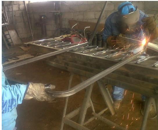
Figura 74 Soldadura de la parte frontal del chasis
